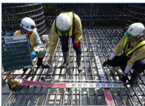
工事の仕上りを管理する堀部さん
