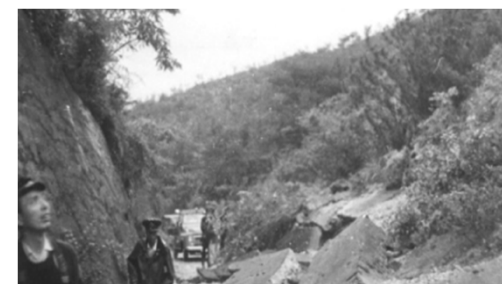
通行止めになった県道
