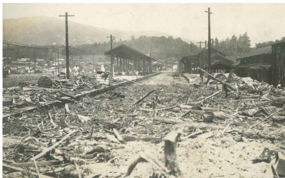
四ッ目川災害(中津川駅構内)
