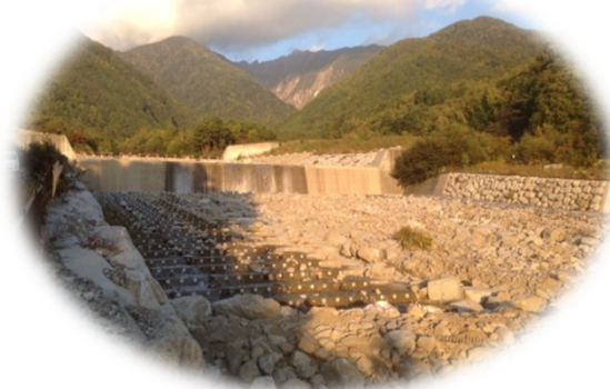
滑川床固め工 (北股沢) (上松町)
