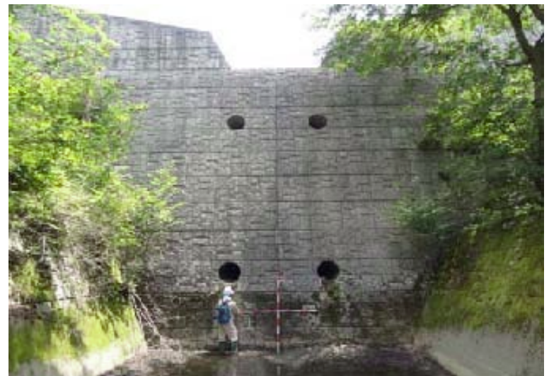
方月第1砂防堰堤(改築)
