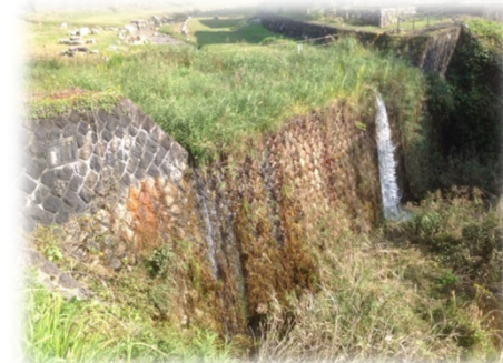
山神砂防堰堤(中津川市)
