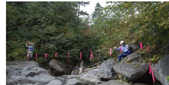
ワイヤーセンサー設置の状況
