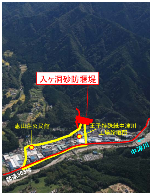
4. 入ヶ洞砂防堰堤(中津川市)
