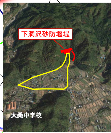
5. 下洞沢砂防堰堤(大桑村)
