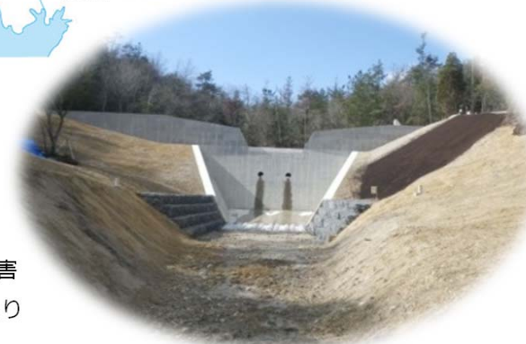
下阿庄砂防堰堤 (土岐市)
