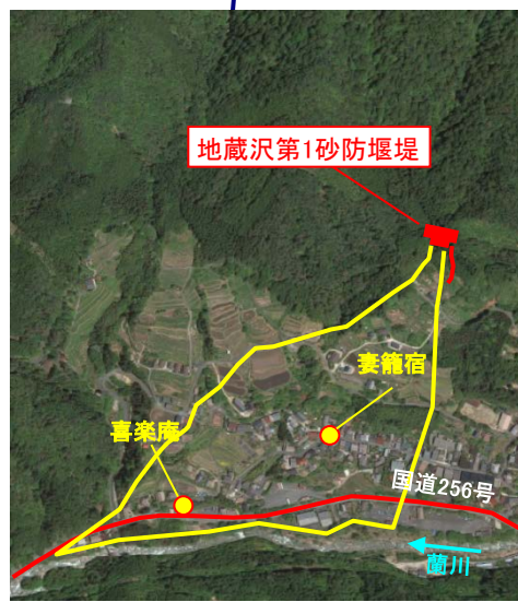
13. 地蔵沢第1砂防堰堤(南木曾町)
