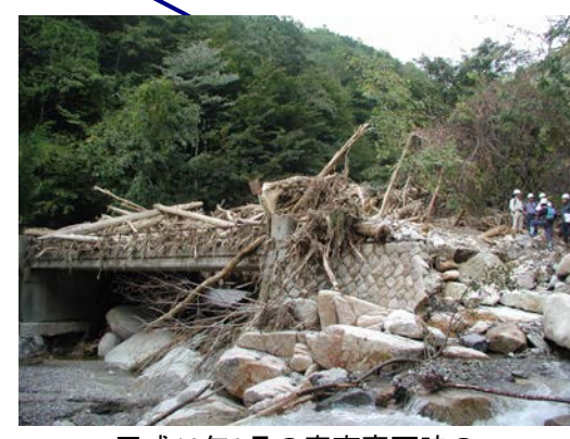
平成12年9月の恵南豪雨時の流木による被災状況(中津川支川一ノ沢)
