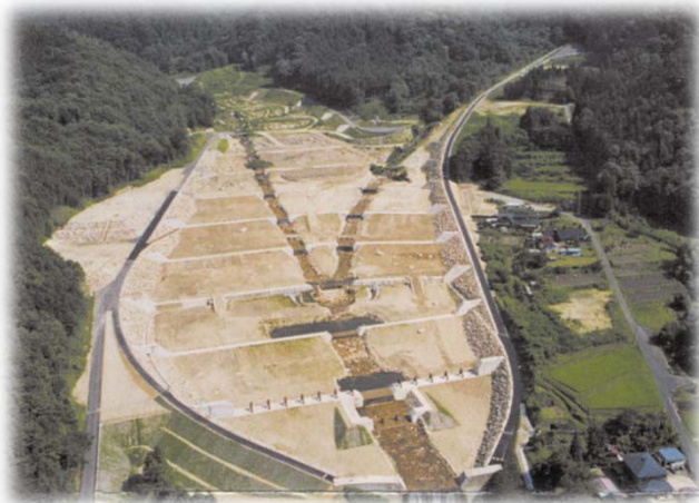
四ツ目川遊砂工
