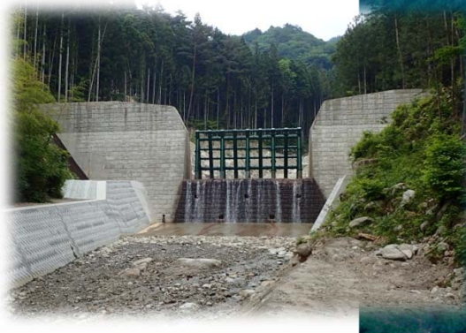
梨子沢第2砂防堰堤
