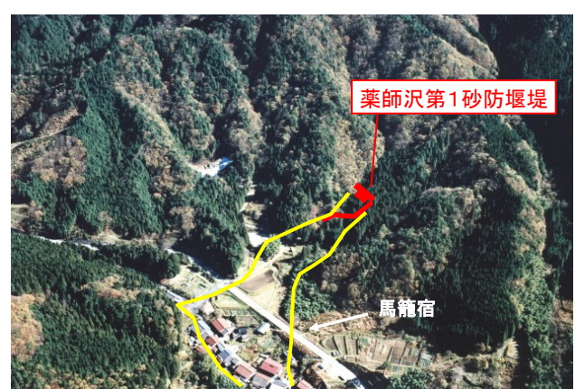
2.薬師沢第1砂防堰堤(中津川市)
