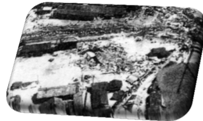
中津川市内の被災状況
