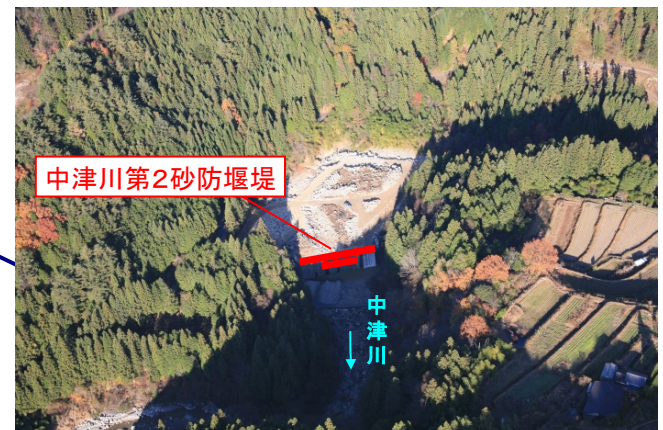
5. 中津川管内施設改築(中津川市)
