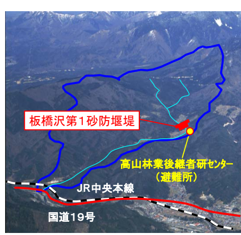
2. 板橋沢第1砂防堰堤(上松町)
