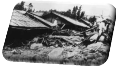
中津川市内の被災状況
