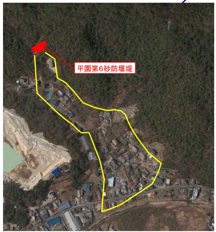
2.平園第6砂防堰堤(多治見市)
