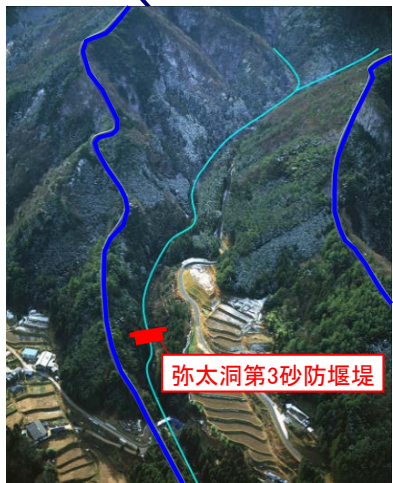
7.弥太洞第3砂防堰堤(中津川市)
