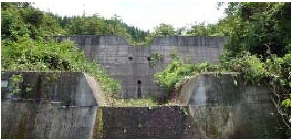
草口第1砂防堰堤(改築)
