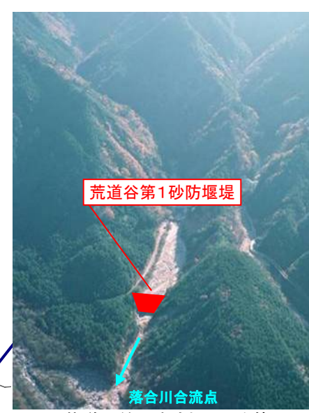
9.荒道谷第1砂防堰堤(改築)(中津川市)
