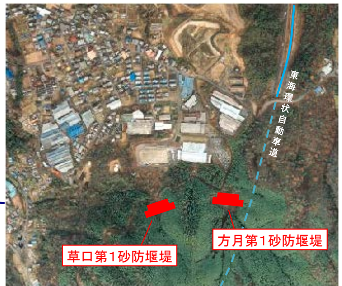
1.妻木管内砂防施設改築(多治見市)
