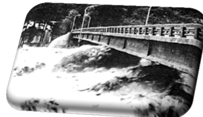
南木曽橋の主桁にせまる濁流 〈出典：「中部の水害」〉
