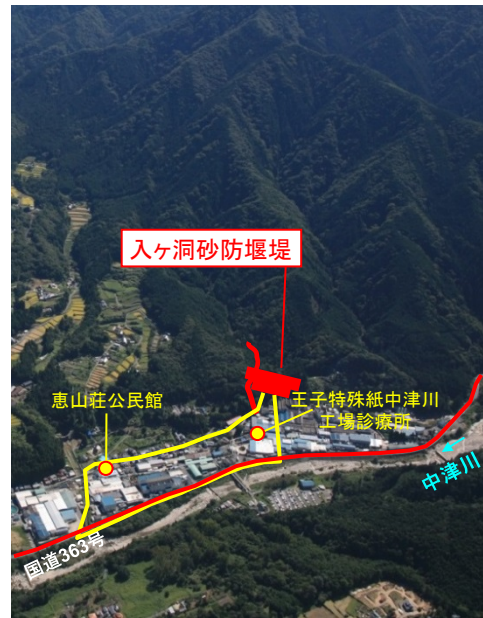
4.入ヶ洞砂防堰堤(中津川市)
