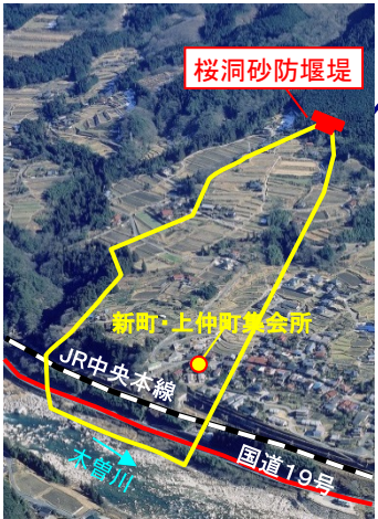
12. 桜洞砂防堰堤(南木曾町)
