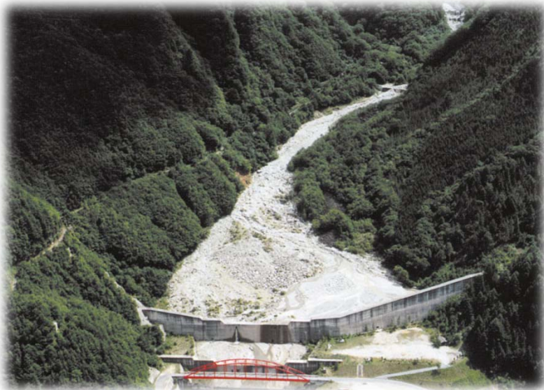
滑川第1砂防堰堤
