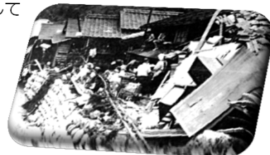
土石流に破壊された家屋
