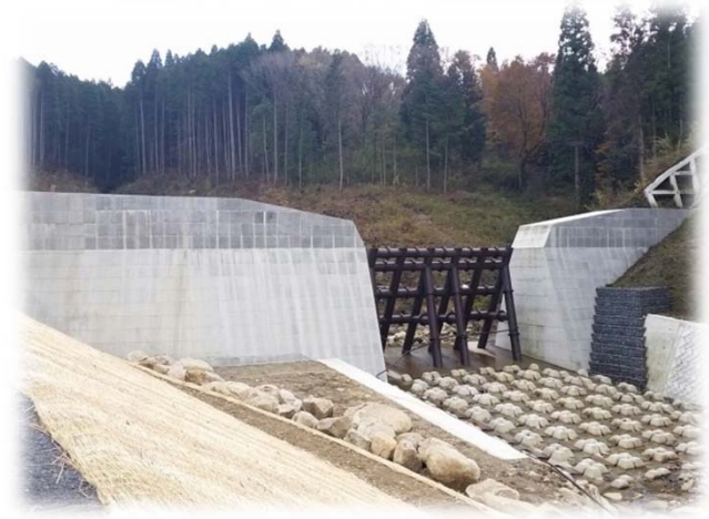
鍛冶ヶ入川第5砂防堰堤
