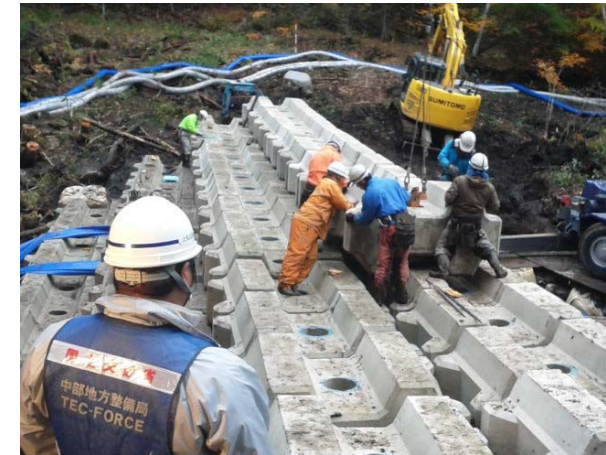
ブロック積み砂防堰堤設置の状況
