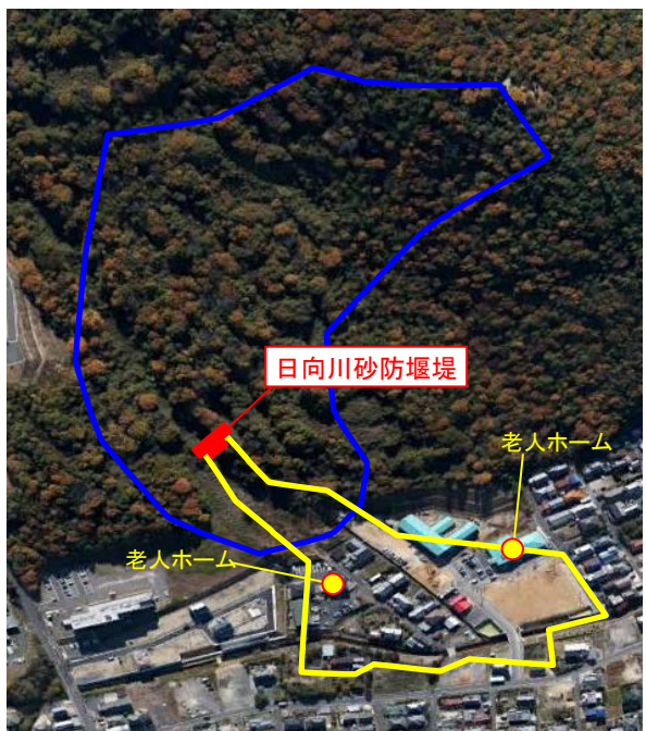
3.日向川砂防堰堤(多治見市)
