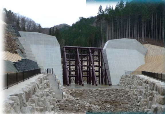
丸山沢第2砂防堰堤
