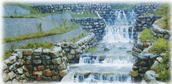
景観に配慮した島田床固工群(中津川市)
