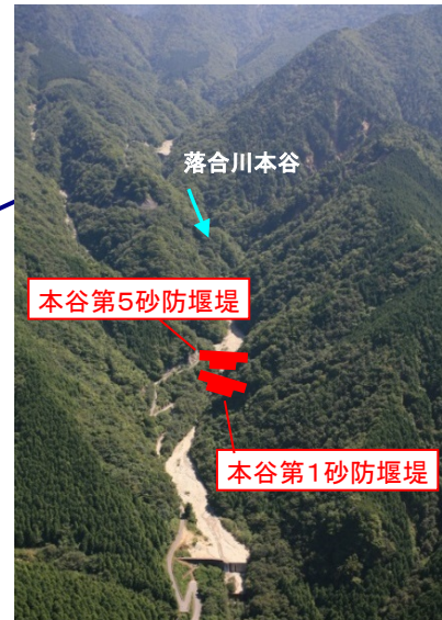
3.本谷砂防堰堤(改築)(中津川市)
