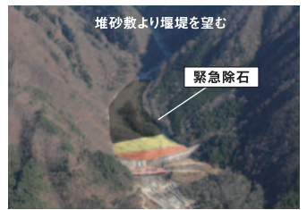
13.滑川第1砂防堰堤除石(上松町)
