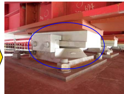
橋梁 損傷部位補修完了
