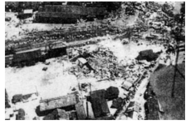
中津川市内の被災状況
