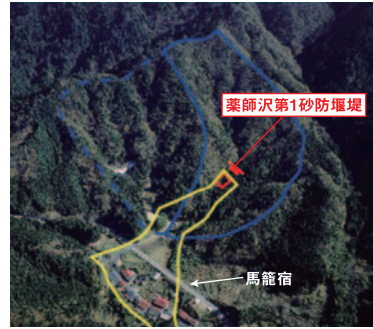
2.薬師沢第1砂防堰堤(中津川市)
