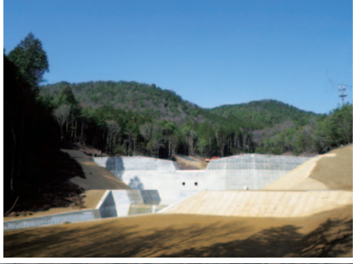
雲五川床固工群(流路工)
