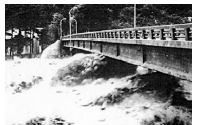
南木曾橋の主桁にせまる濁流(出典:「中部の水害」)
