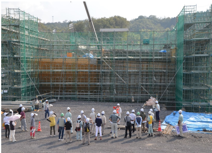
道路現場見学(坂祝バイパス黒岩地区道路建設工事)
