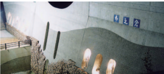
市之倉おりべ砂防堰堤 (多治見市)
