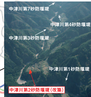
7.中津川第2砂防堰堤(改築)(中津川市)
