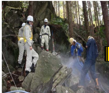
現場施工の立会監督
