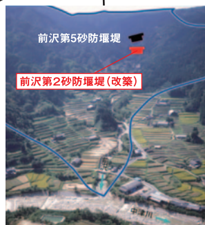
7.前沢第2砂防堰堤(改築)(中津川市)
