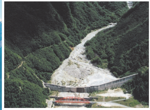
額付第2砂防堰堤
