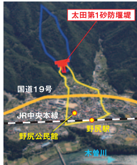
7.太田第1砂防堰堤(大桑村)
