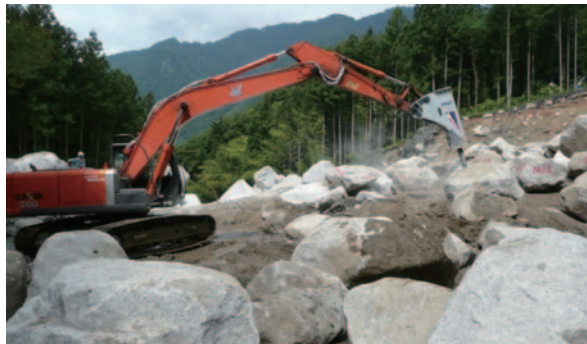
堆積した土砂等の撤去(除石)状況
