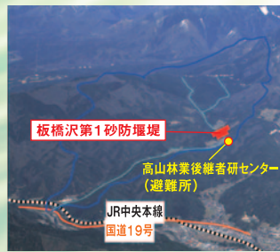
2.板橋沢第1砂防堰堤(上松町)
