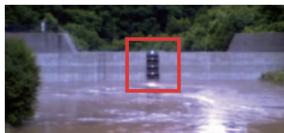
上山沢第1砂防堰堤
