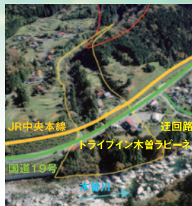
3.大沢第1砂防堰堤(上松町)
