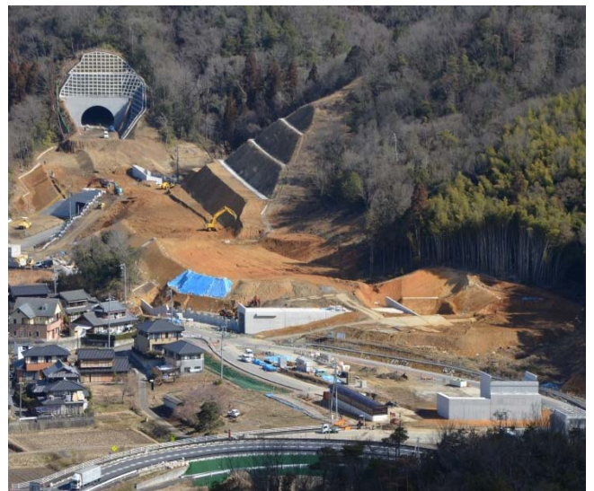
・勝山ICから坂祝第2トンネル方向を望む
