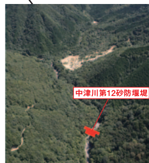
5.中津川第12砂防堰堤(中津川市)
