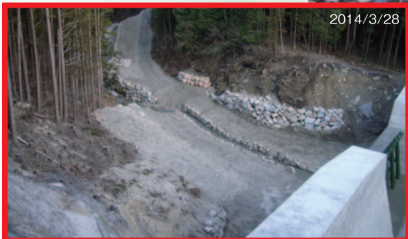
災害前の梨子沢第2砂防堰堤(空っぽの状態)
