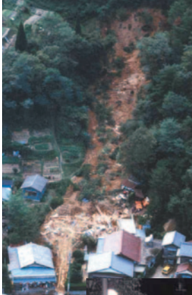
崩壊した斜面 (土岐市西山)
