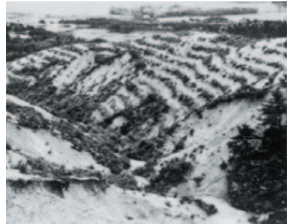
昭和20年代後半 山腹工施工(昭和27~28年)
