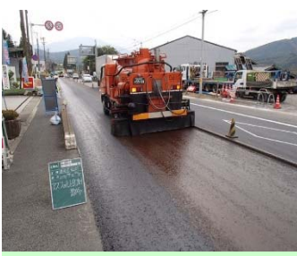
舗装工事の実施
