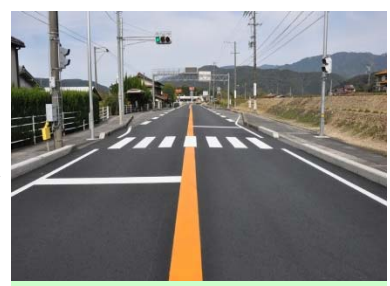
舗装工事の完成
