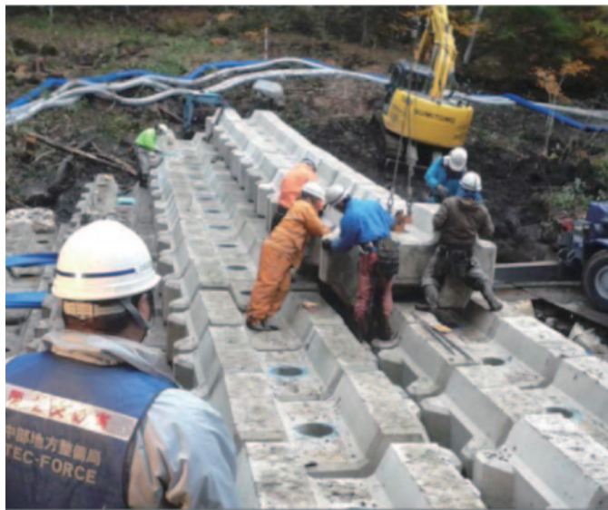
テックフォースによる活動状況(ブロック積み砂防堰堤設置の状況)
