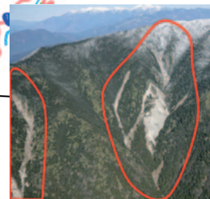
中津川(一ノ沢上流)の荒廃状況
