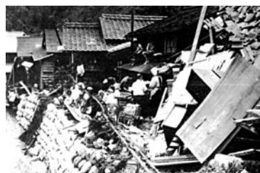
土石流に破壊された家屋
