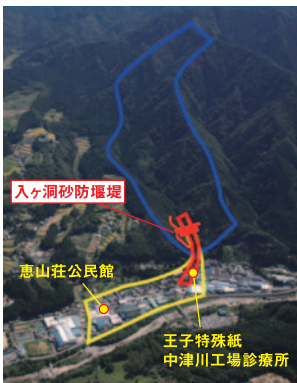
4.入ヶ洞砂防堰堤(中津川市)
