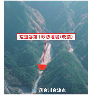
7.荒道谷第1砂防堰堤(改築) (中津川市)
