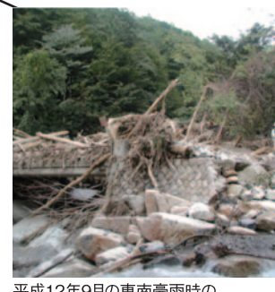
平成12年9月の恵南豪雨時の 流木による被災状況(中津川支川一ノ沢)
