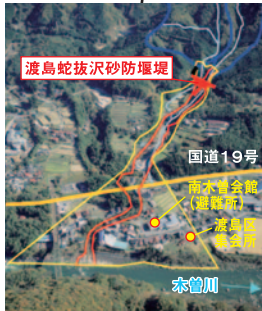
8.渡島蛇抜沢砂防堰堤(南木曾町)
