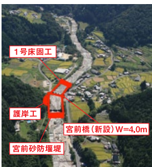
1.川上流路工改築(中津川市)
