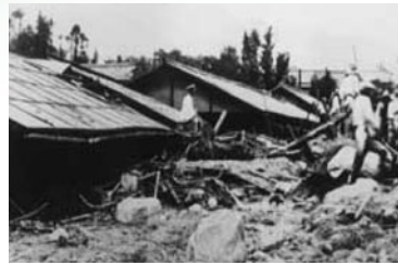
中津川市内の被災状況
