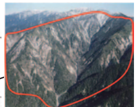
越百川第3砂防堰堤の上流部の崩壊地状況
