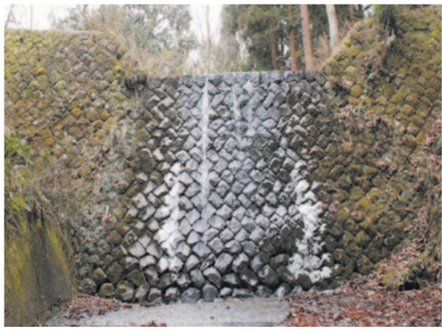
大沢川砂防堰堤
