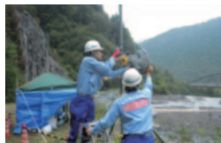
監視カメラ設置の状況
