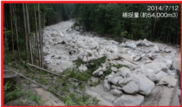
災害後の土砂等の捕捉状況
