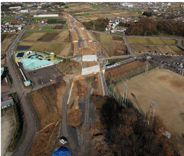
・坂祝第1トンネルから大針IC方向を望む
