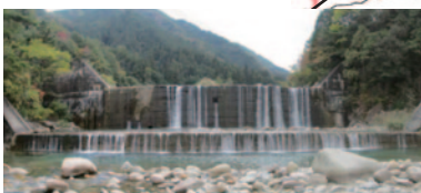
7.牛ヶ瀬砂防堰堤改築(中津川市)
