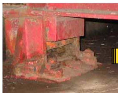
損傷部位の確認・台帳作成
