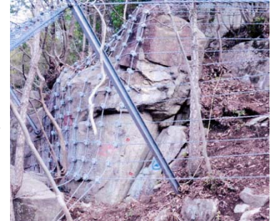
落石防止対策完了
