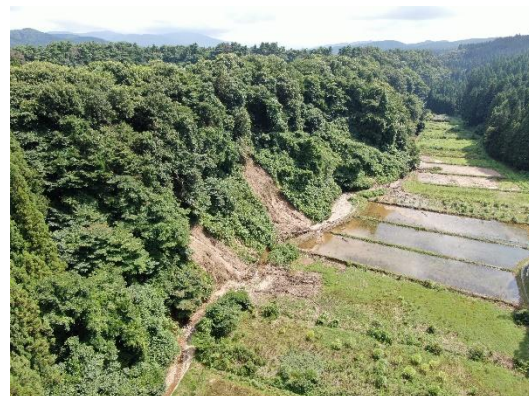
UAVによる被災状況調査
