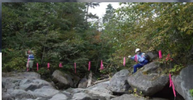
ワイヤーセンサーの設置状況
