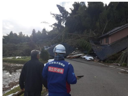
地元の方への被災状況聞き取り
