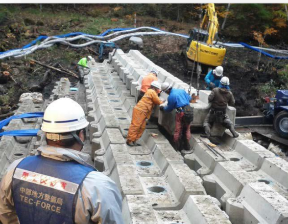
ブロック積み砂防堰堤設置の状況
