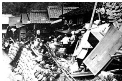
土石流に破壊された家屋
