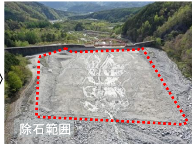
土砂移動発生前 令和2年5月
