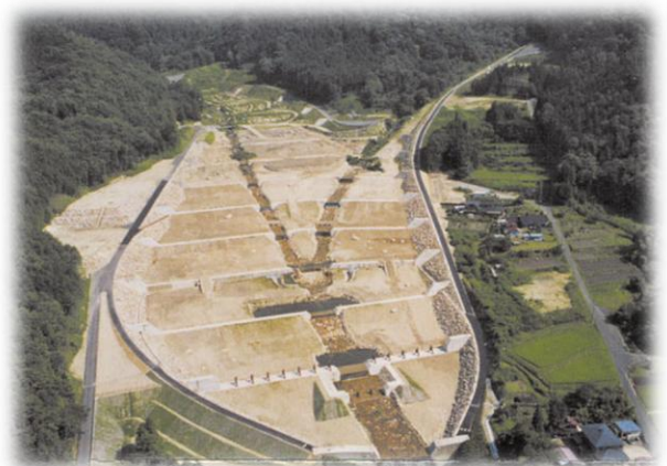
四ツ目遊砂工【中津川市】
