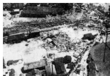
中津川市内の被災状況
