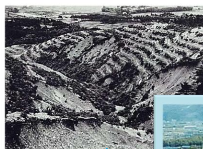
昭和20年代後半山腹工施工（昭和27～28年）
