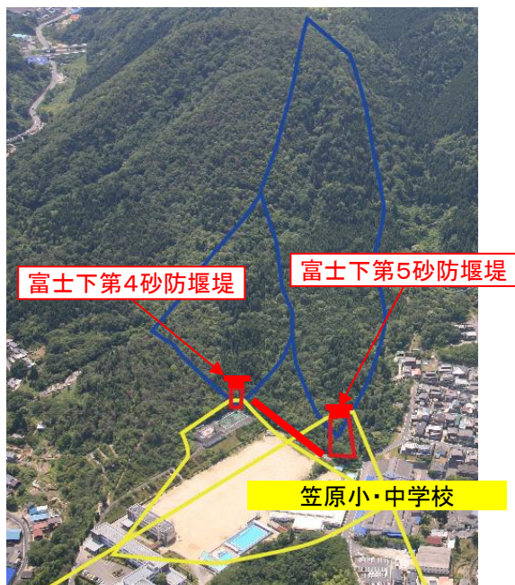
3.富士下砂防堰堤工群(多治見市)
