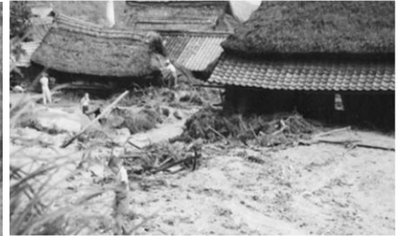
土砂流出により埋まった家屋
