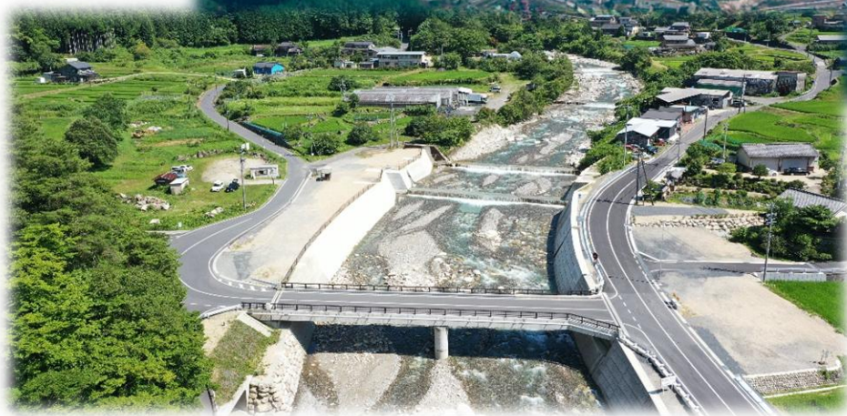
川上流路工 [中津川市]
