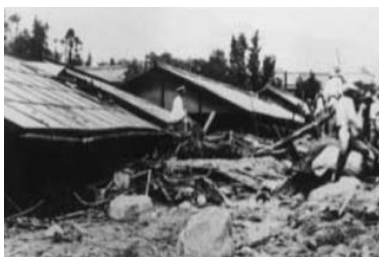
中津川市内の被災状況
