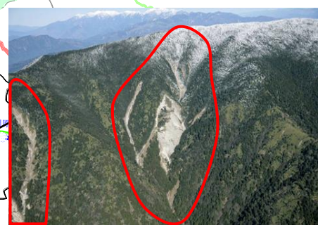
中津川上流の荒廃状況
