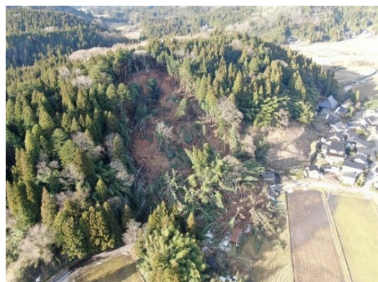
UAVによる被災状況調査
