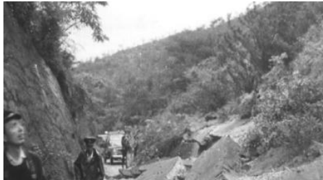
通行止めになった県道
