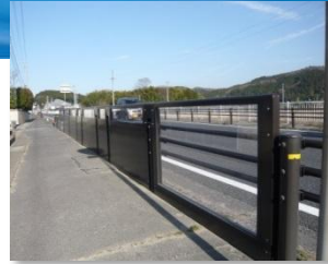
●騒音対策(低層遮音壁)の実施状況(瑞浪市釜戸町)
