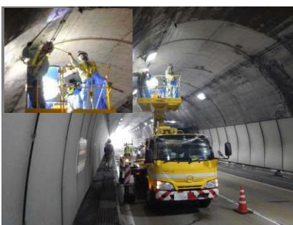
トンネル点検（高所作業車）
