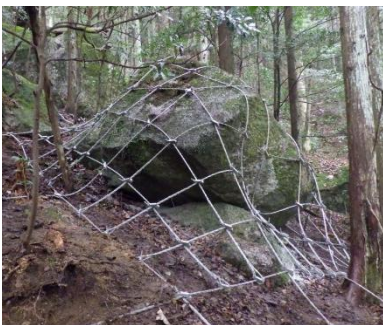
落石防止網(ロープ伏)工
