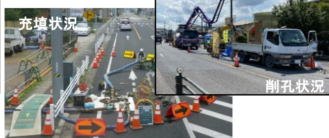
亜炭坑充填工事の様子
