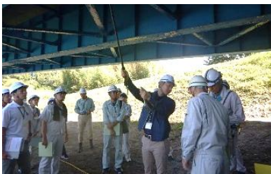
橋梁点検講習会
