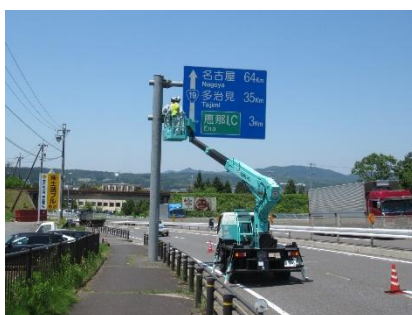
標識点検（高所作業車）
