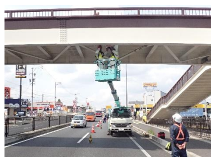
歩道橋点検（高所作業車）
