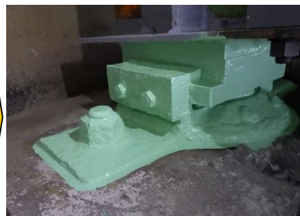
損傷部位の補修
