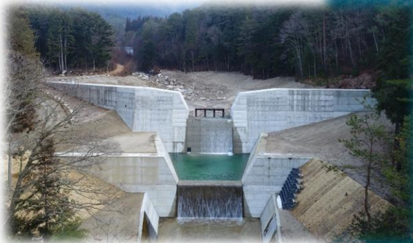
額付第1砂防堰堤 [南木曾町]
