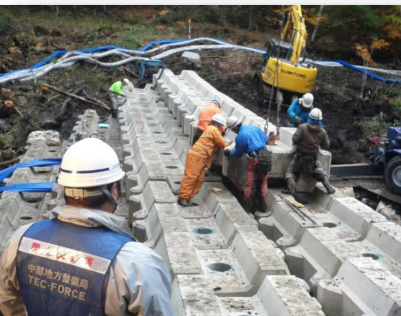
ブロック積み砂防堰堤設置の状況
