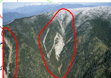
中津川上流の荒廃状況
