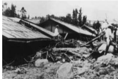
中津川市内の被災状況
