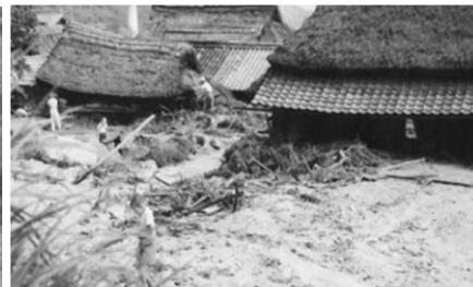
土砂流出により埋まった家屋
