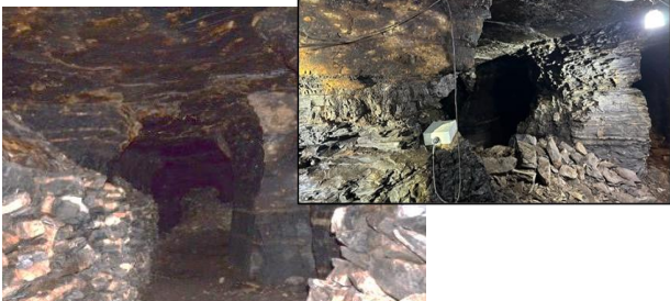
亜炭採掘跡(廃坑内部の様子)
