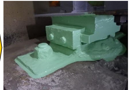
損傷部位の補修
