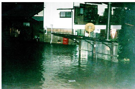
土岐市内の浸水状況
