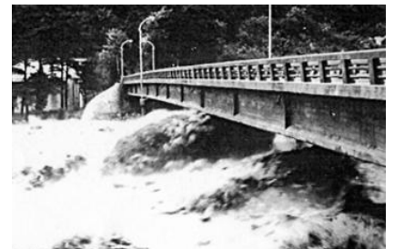
南木曽橋の主桁にせまる濁流 〈出典：「中部の水害」〉
