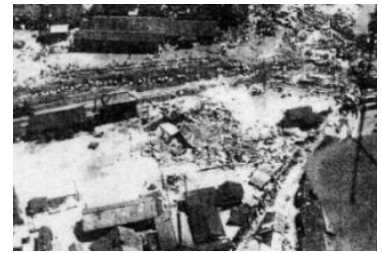
中津川市内の被災状況
