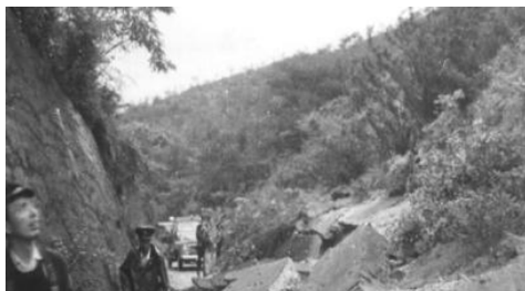
通行止めになった県道
