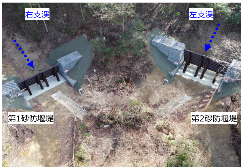
星ヶ台砂防堰堤（堤長：第1:15.6m、第2:18.2m 堤高：第1: 4.0m、第2: 5.3m）
