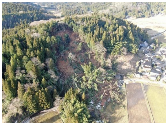
UAVによる被災状況調査
