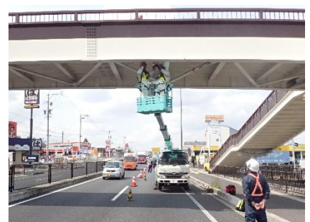
歩道橋点検(高所作業車)
