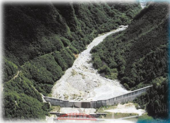
滑川第1砂防堰堤 [上松町]
