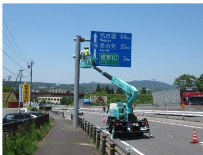
標識点検(高所作業車)
