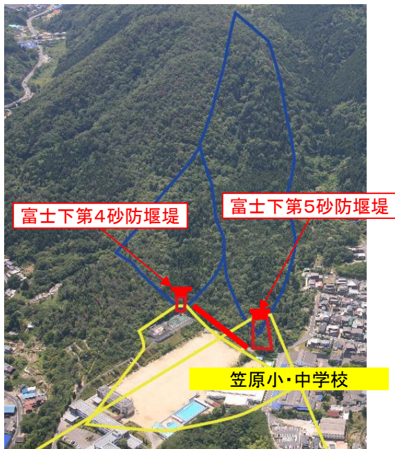
3.富士下砂防堰堤工群（多治見市）
