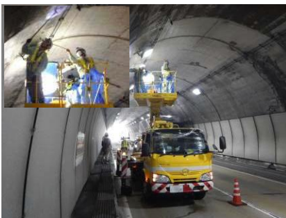
トンネル点検(高所作業車)
