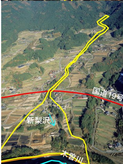
2.新梨沢砂防堰堤(中津川市)
