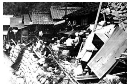
土石流に破壊された家屋
