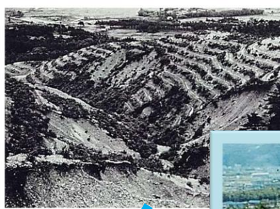
昭和20年代後半 山腹工施工（昭和27~28年）
