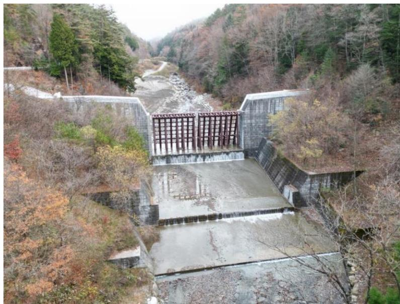
改築後（透過型砂防堰堤）
