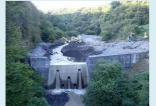
砂防堰堤の除石(湯川、長野県)
