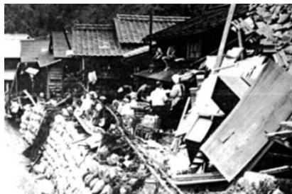
土石流に破壊された家屋
