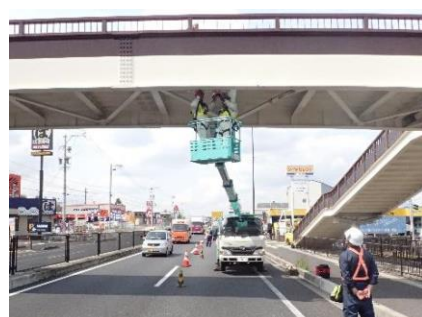
歩道橋点検（高所作業車）
