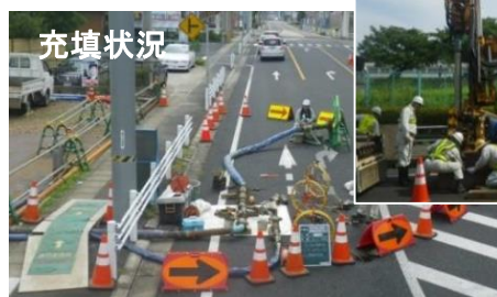
亜炭坑充填工事の様子
