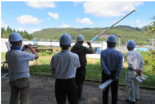
道路工事現場見学(瑞浪恵那道路3号橋)
