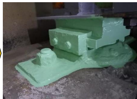
損傷部位の補修
