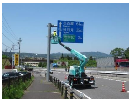
標識点検（高所作業車）
