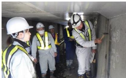
打音検査の実習
