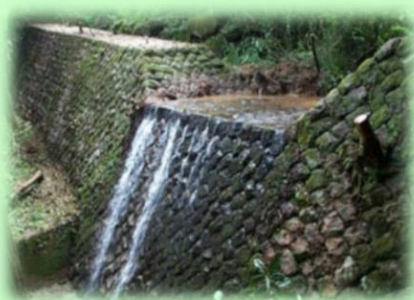
浦山第2砂防堰堤
