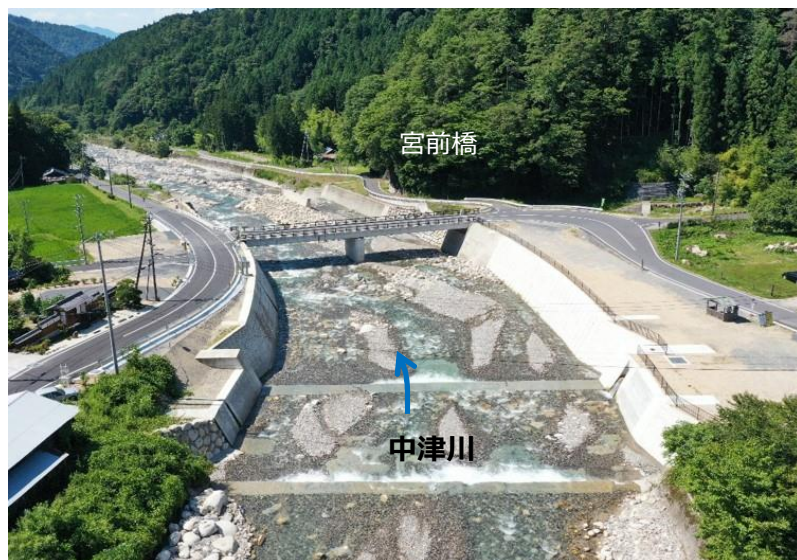
川上流路工（延長1,469m、砂防堰堤2基、床固工13基、帯工2基）
