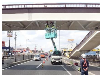
歩道橋点検（高所作業車）
