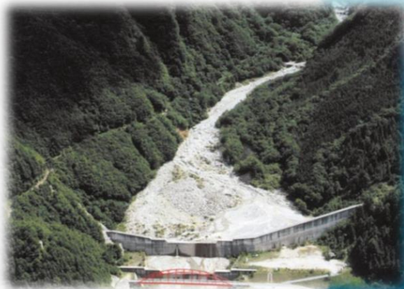
滑川第1砂防堰堤〔上松町〕
