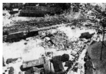
中津川市内の被災状況
