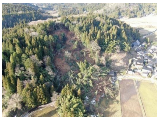
UAVによる被害状況調査
