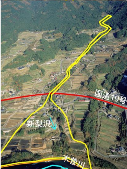
2.新梨沢砂防堰堤（中津川市）
