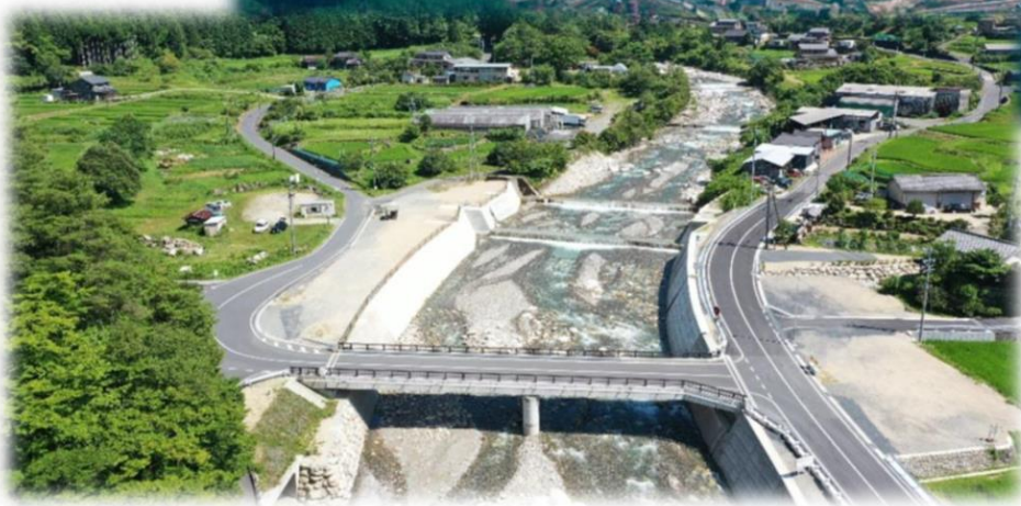
川上流路工〔中津川市〕
