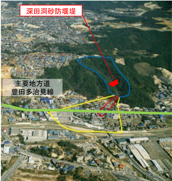
4.深田洞砂防堰堤(多治見市)
