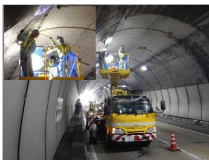
トンネル点検（高所作業車）
