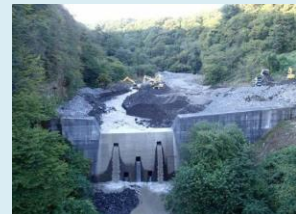
砂防堰堤の除石 (湯川、長野県)
