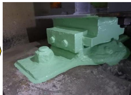
損傷部位の補修
