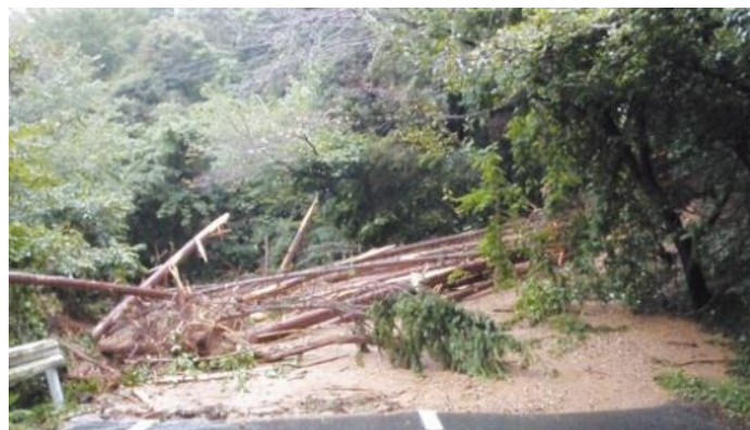
道路を塞ぐ土石流(多治見市)
