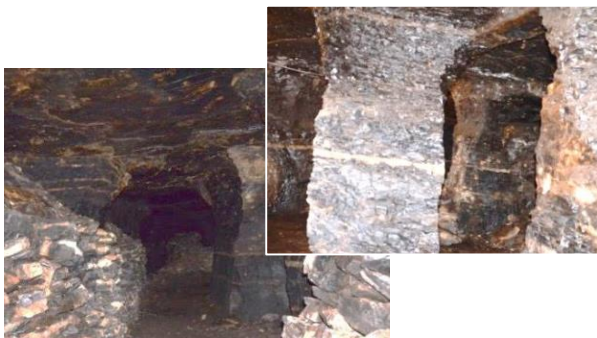
亜炭採掘跡(廃坑内部の様子)
