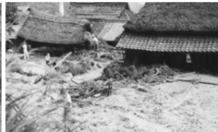
土砂流出により埋まった家屋
