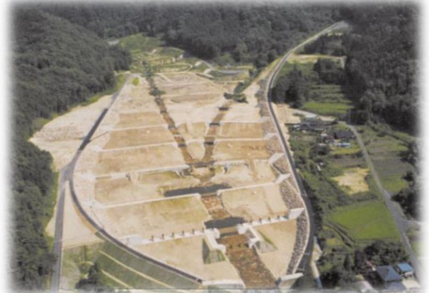
四ツ目遊砂工 [中津川市]
