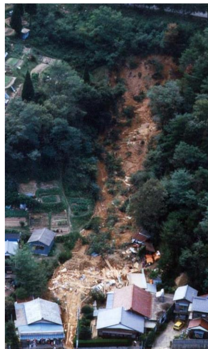
崩壊した斜面（土岐市西山）
