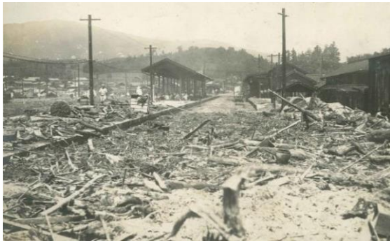
四ッ目川災害(中津川駅構内)
