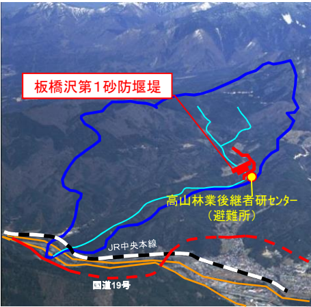
1.板橋沢第1砂防堰堤(上松町)
