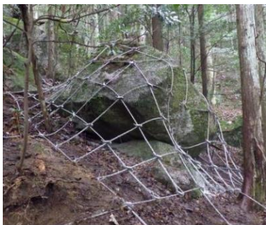
落石防止網(ロープ伏)工
