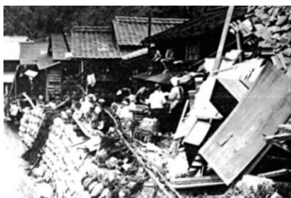
土石流に破壊された家屋
