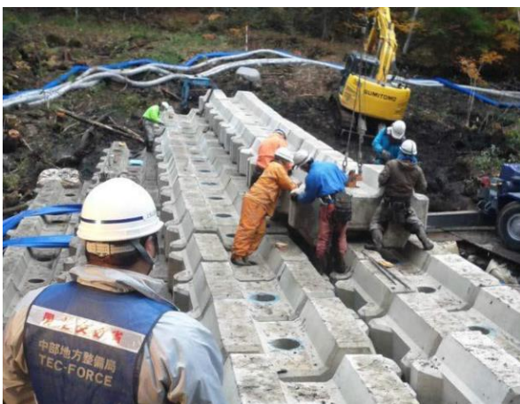
ブロック積み砂防堰堤設置の状況
