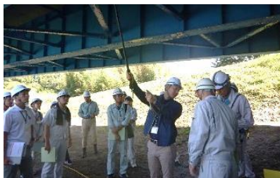
橋梁点検講習会
