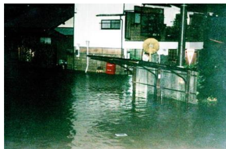
土岐市内の浸水状況
