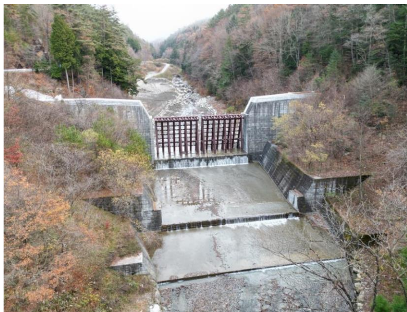
改築後（透過型砂防堰堤）
