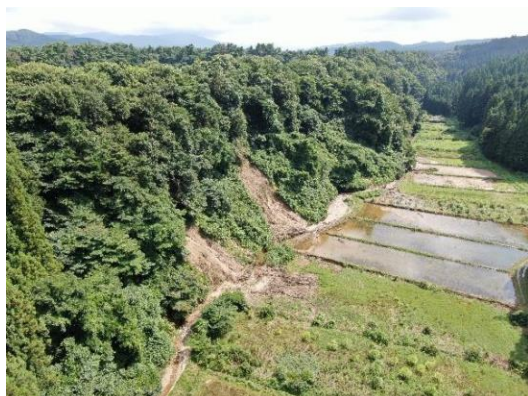
UAVによる被害状況調査
