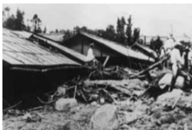
中津川市内の被災状況
