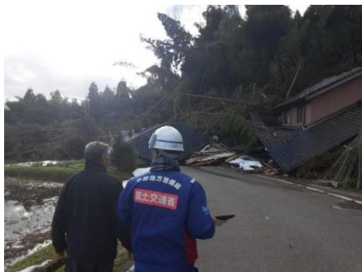
地元の方への被害状況聞き取り
