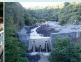
砂防堰堤の除石 (湯川、長野県)
