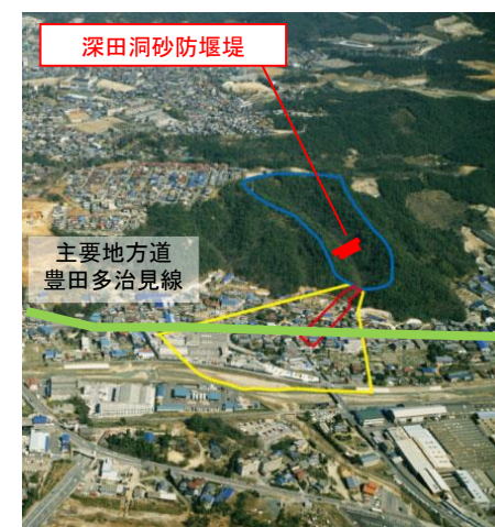
4.深田洞砂防堰堤（多治見市）
