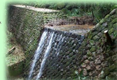
浦山第2砂防堰堤
