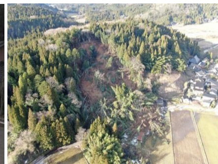
UAVによる被害状況調査
