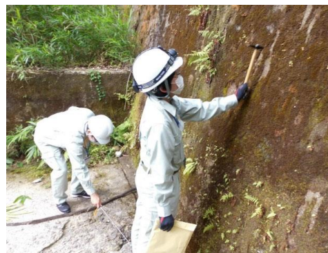
砂防施設の点検(打音検査) (多治見市:砦山第7砂防堰堤)
