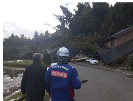
地元の方への被害状況聞き取り
