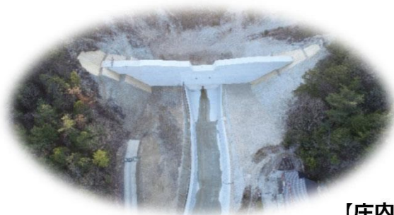
庄内川水系 平園第6砂防堰堤【多治見市】
