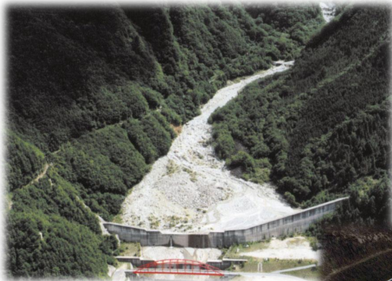
滑川第1砂防堰堤【上松町】
