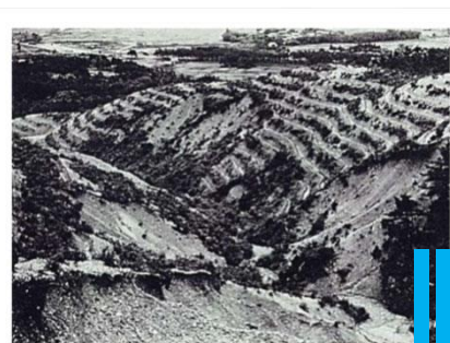
昭和20年代後半 山腹工施工（昭和27~28年）
