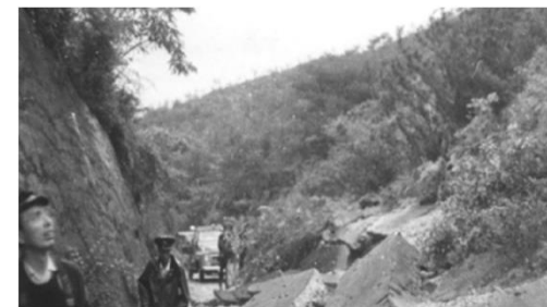
通行止めになった県道
