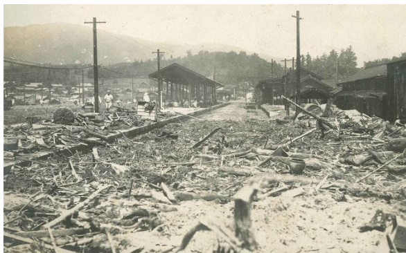
四ッ目川災害(中津川駅構内)
