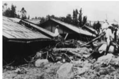
中津川市内の被災状況
