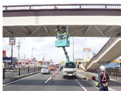
歩道橋点検（高所作業車）
