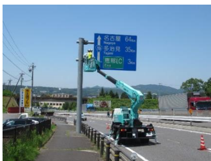
標識点検（高所作業車）
