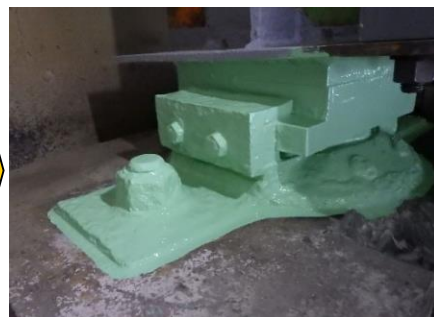
損傷部位の補修
