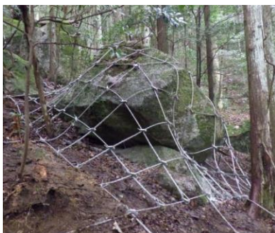
落石防止網(ロープ伏)工
