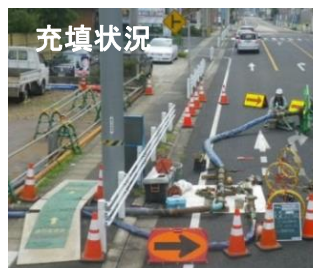
亜炭坑充填工事の様子
