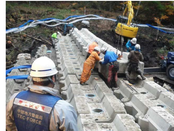
ブロック積み砂防堰堤設置の状況
