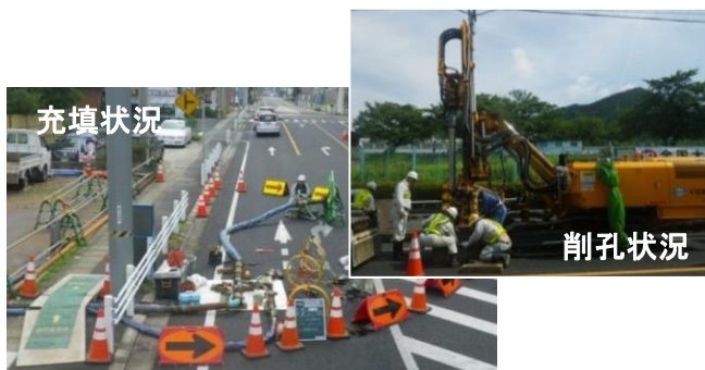
亜炭坑充填工事の様子
