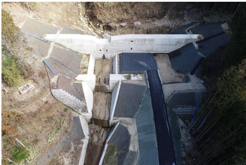
<薬師沢第1砂防堰堤と下流の保全対象>
