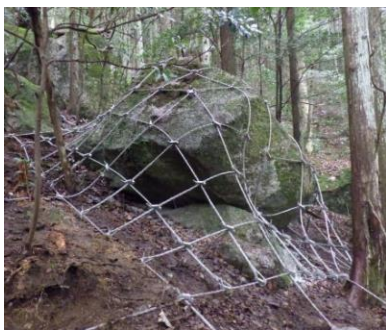
落石防止網(ロープ伏)工
