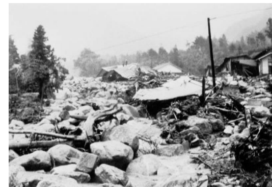
南木曽災害(南木曽町内)
