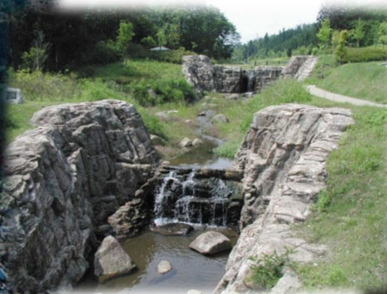
雲五川床固工群（流路工）【土岐市】
