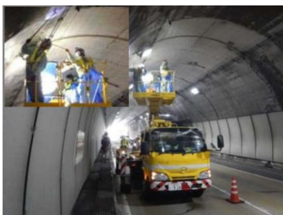
トンネル点検（高所作業車）
