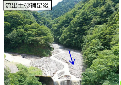
本谷第1砂防堰堤（中津川市）
