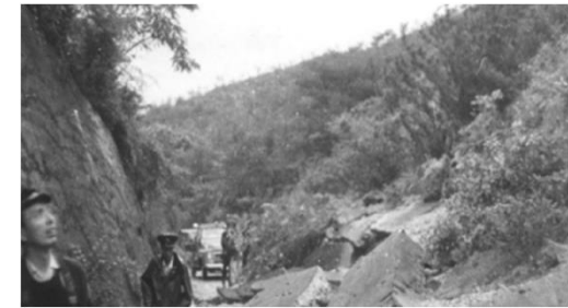
通行止めになった県道
