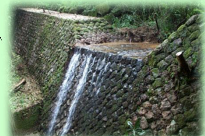
浦山第2砂防堰堤
