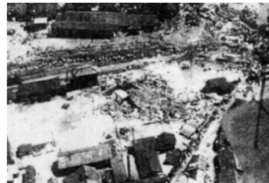
中津川市内の被災状況
