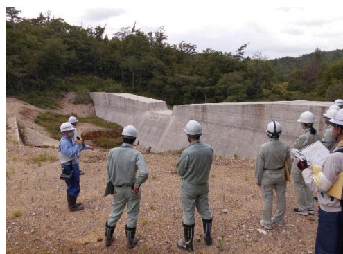
砂防施設の点検 (多治見市: 砦山第4砂防堰堤)
