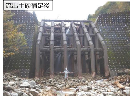
地獄谷第4砂防堰堤（中津川市）
