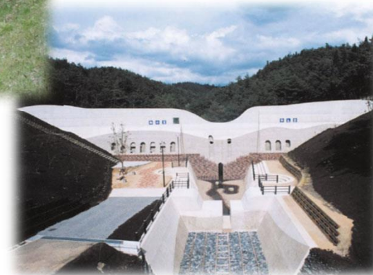
市之倉おりべ砂防堰堤（中峰谷第1砂防堰堤）【多治見市】
