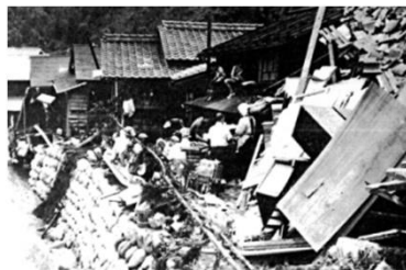
土石流に破壊された家屋
