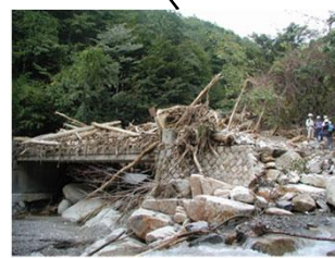
平成12年9月の恵南豪雨時の 流木による被災状況（中津川支川一ノ宮）
