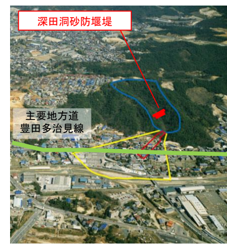
4.深田洞砂防堰堤（多治見市）
