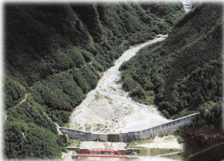
滑川第1砂防堰堤 [上松町]
