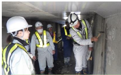
打音検査の実習
