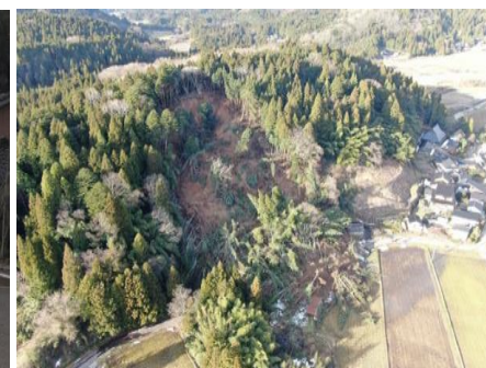
UAVによる被害状況調査
