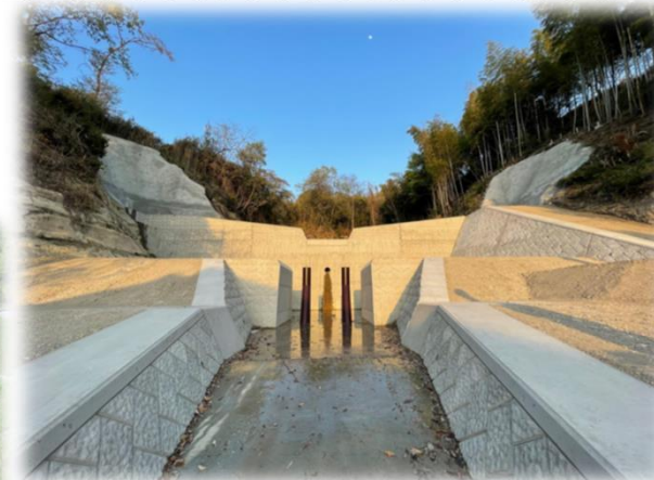
一の洞第2砂防堰堤【土岐市】
