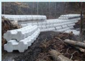
コンクリートブロック積み砂防堰堤 (鹿ノ瀬川、国土交通省中部地方整備局)
