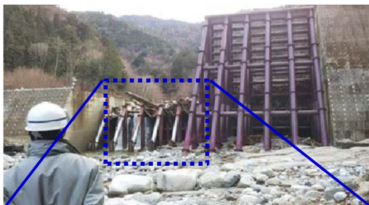
＜整備途中における土砂等の捕捉＞
