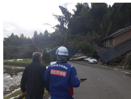
地元の方への被害状況聞き取り
