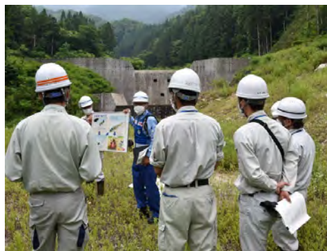
砂防施設点検の説明 (南木曽町:梨子沢第3砂防堰堤)
