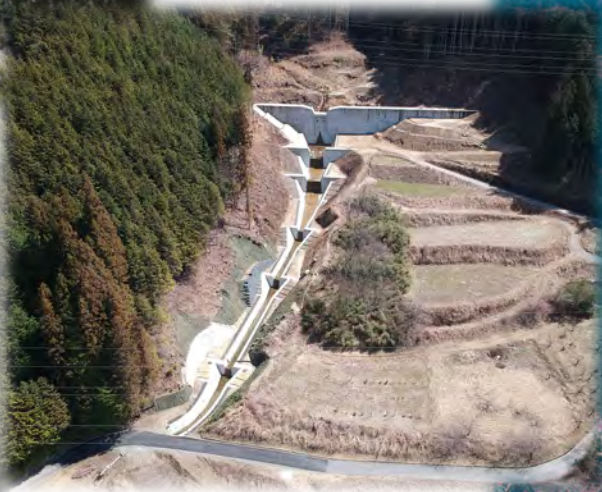
下洞沢砂防堰堤〔大桑村〕
