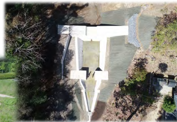
町砂防堰堤【土岐市】
