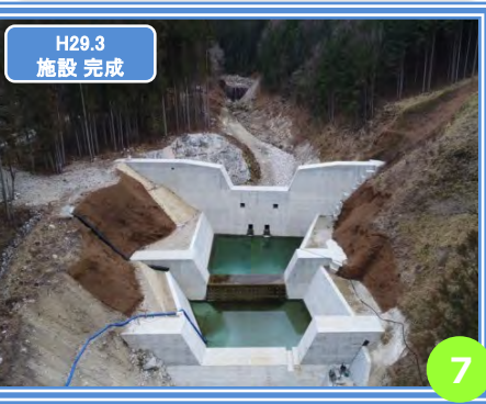
＜ 梨子沢第4砂防堰堤 ＞
