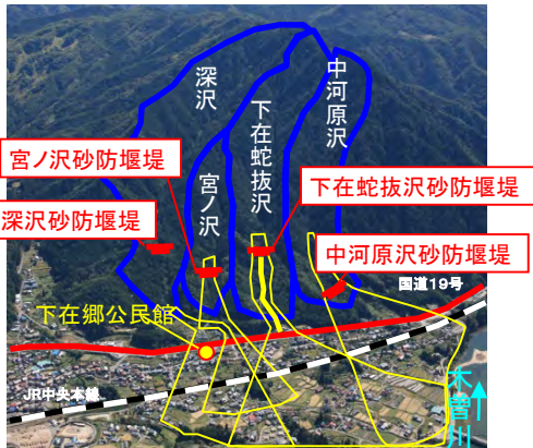
9.下在砂防堰堤工群(大桑村)
