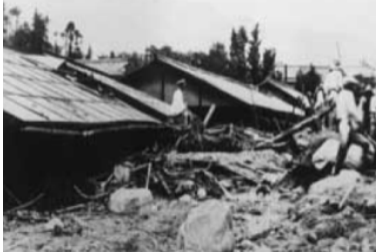
中津川市内の被災状況
