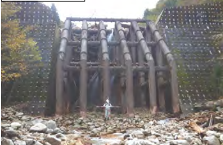
地獄谷第4砂防堰堤（中津川市）
