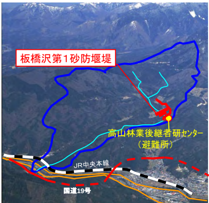
1.板橋沢第1砂防堰堤(上松町)
