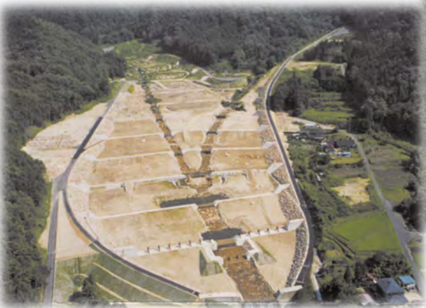
四ッ目川遊砂工〔中津川市〕
