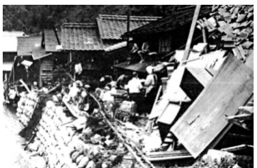
土石流に破壊された家屋
