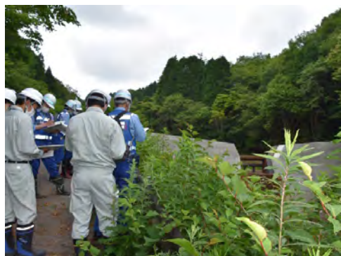
砂防施設の点検 (多治見市:市之倉第3砂防堰堤)
