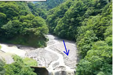
本谷第1砂防堰堤（中津川市）
