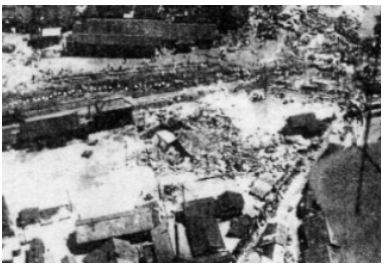
中津川市内の被災状況
