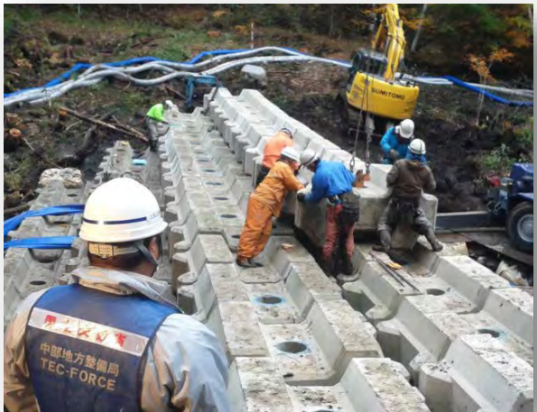
ブロック積み砂防堰堤設置の状況
