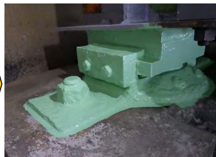
損傷部位の補修
