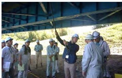
橋梁点検講習会
