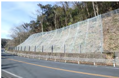
落石防止網工
