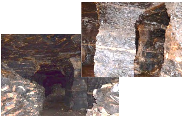
亜炭採掘跡(廃坑内部の様子)
