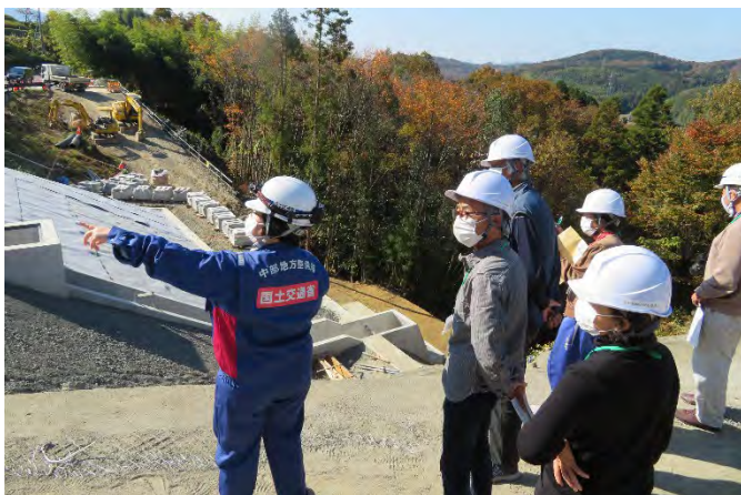
道路工事現場見学(中津川市落合)
