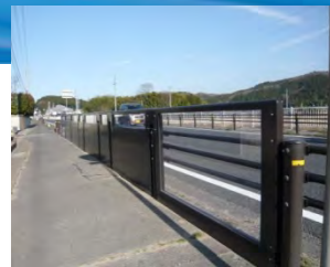
●騒音対策(低層遮音壁)の実施状況(瑞浪市金戸町)
