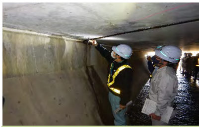
打音検査の実習
