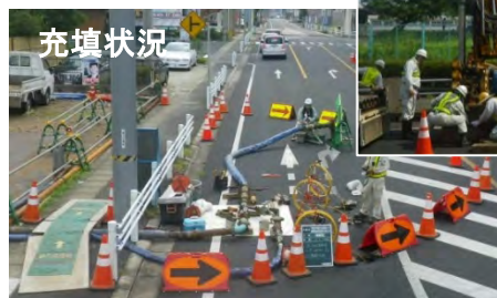
亜炭坑充填工事の様子
