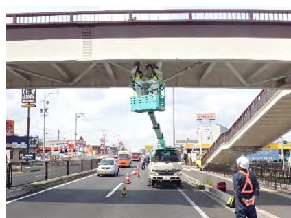
歩道橋点検（高所作業車）
