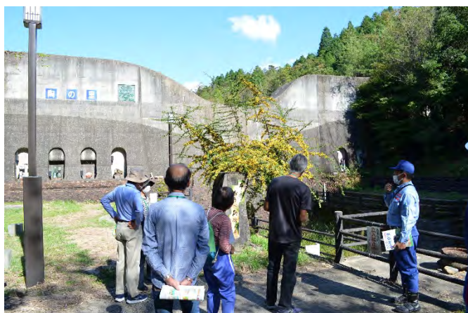
砂防堰堤見学(土岐市:市之倉おりべ砂防ダム)
