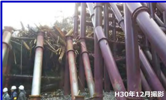
平成30年8～9月の大雨により土石流が発生し、整備途中ではあったものの土砂・流木を捕捉し被害を防止。
