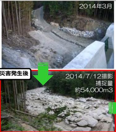
災害後に、緊急的に除石を実施し、その後、副堤を含む砂防堰堤を整備しました。
