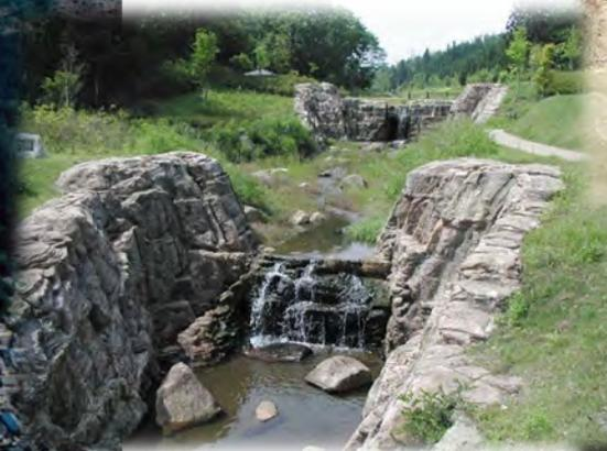
雲五川床固工群（流路工）【土岐市】
