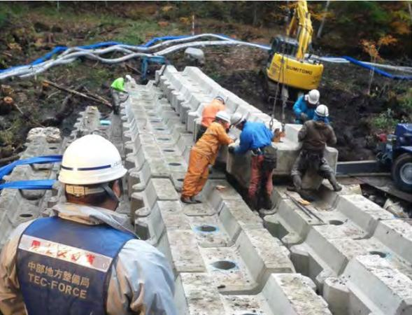
ブロック積み砂防堰堤設置の状況
