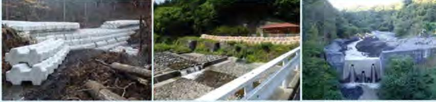
コンクリートブロック積み砂防堰堤
