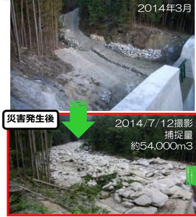
災害後に、緊急的に除石を実施し、その後、副堤を含む砂防堰堤を整備しました。
