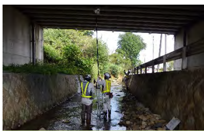
点検支援技術の導入 (ロボットカメラ)
