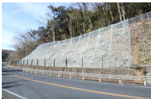
落石防止網工
