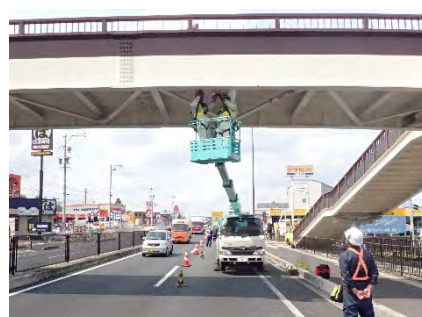
歩道橋点検（高所作業車）
