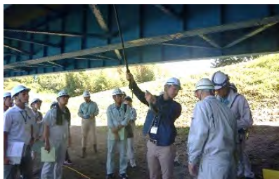
橋梁点検講習会
