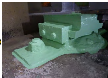
損傷部位の補修
