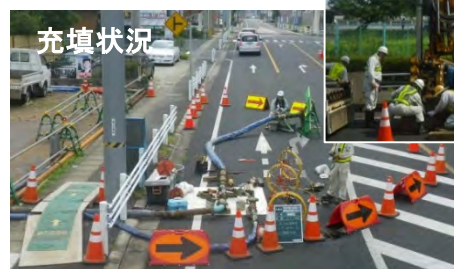
亜炭坑充填工事の様子
