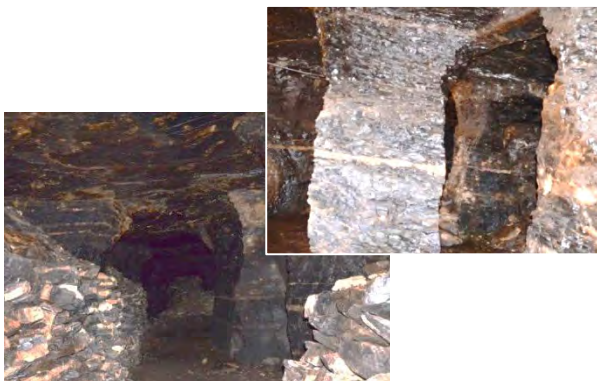
亜炭採掘跡(廃坑内部の様子)
