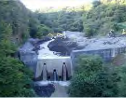
砂防堰堤の除石 (湯川、長野県)
