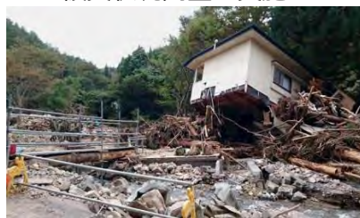
岩手県宮古市白浜地区の土流による被災現場にて調査
