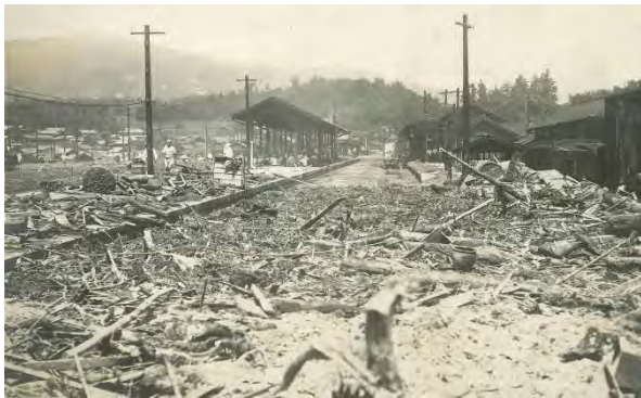
四ッ目川災害(中津川駅構内)
