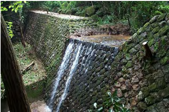
浦山第2砂防堰堤
