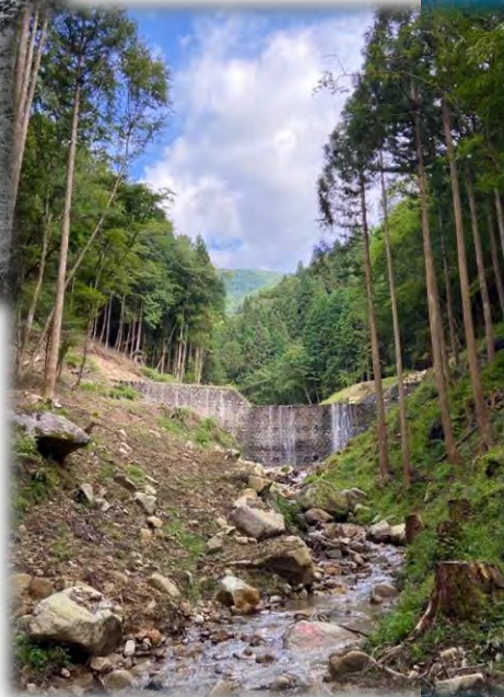
穴ヶ沢第1砂防堰堤（改築）
