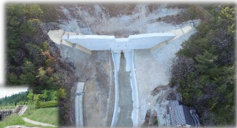
平園第6砂防堰堤
