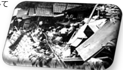
土石流に破壊された家屋
