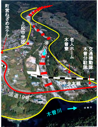
5.滑川下流床固工群（上松町）
