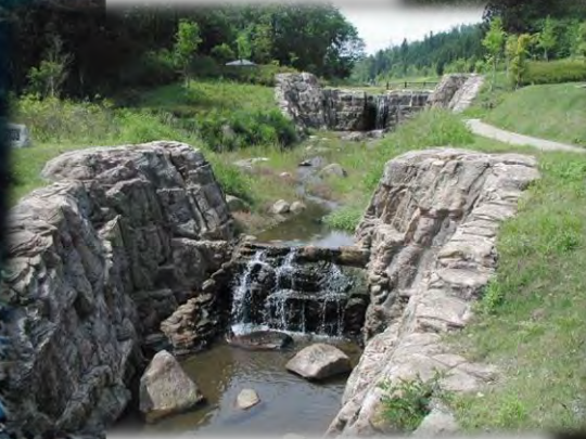
雲五川床固工群（流路工）
