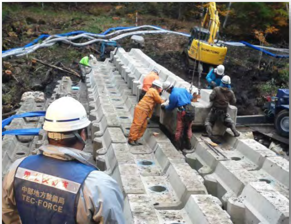
ブロック積み砂防堰堤設置の状況
