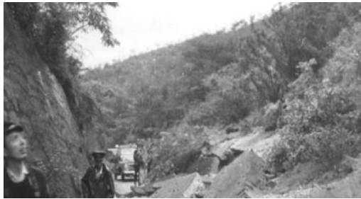
通行止めになった県道
