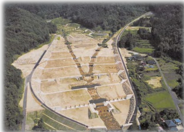
四ッ目川遊砂工
