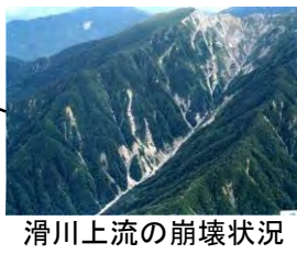
滑川上流の崩壊状況
