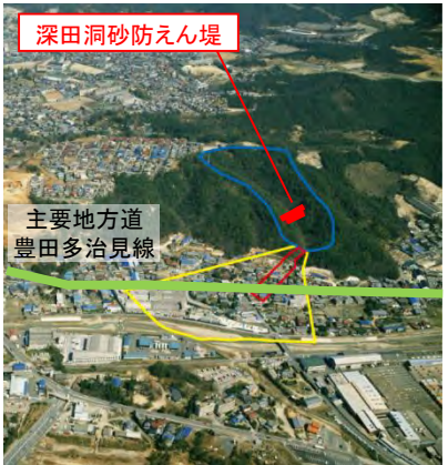
1.深田洞砂防堰堤（多治見市）
