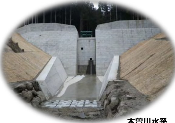
木曽川水系 桜洞砂防堰堤
