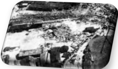
中津川市内の被災状況
