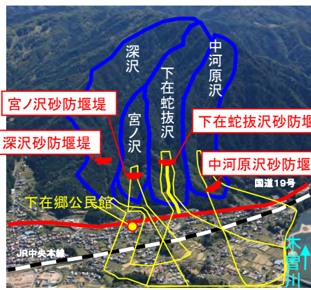
6.下在砂防堰堤工群（大桑村）
