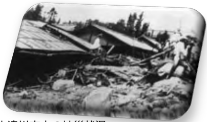
中津川市内の被災状況
