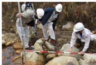
不安定土砂を想定した 渓流点検状況
