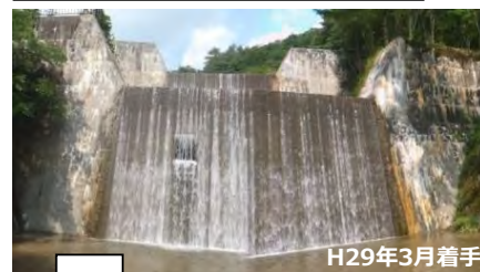
H29年3月着工
