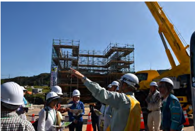
道路工事現場見学(瑞浪恵那道路)
