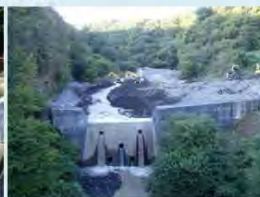
砂防堰堤の除石 (湯川、長野県)
