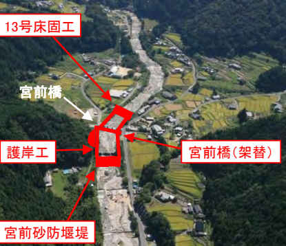
1.川上流路工改築（中津川市）
