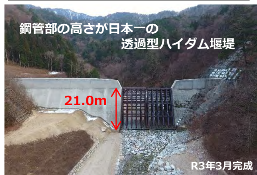
鋼管部の高さが日本一の透過型ハイダム堰堤 R3年3月完成
