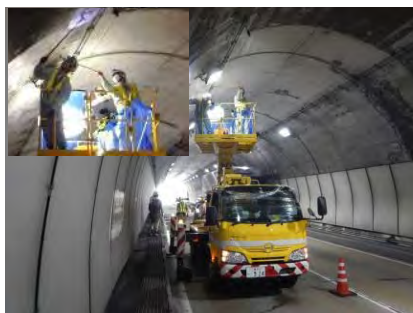
トンネル点検（高所作業車）
