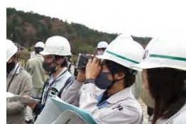
レーザー測距儀による 距離計測
