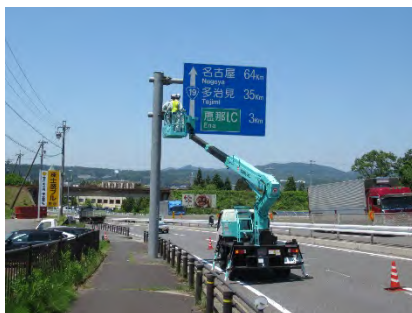
標識点検（高所作業車）
