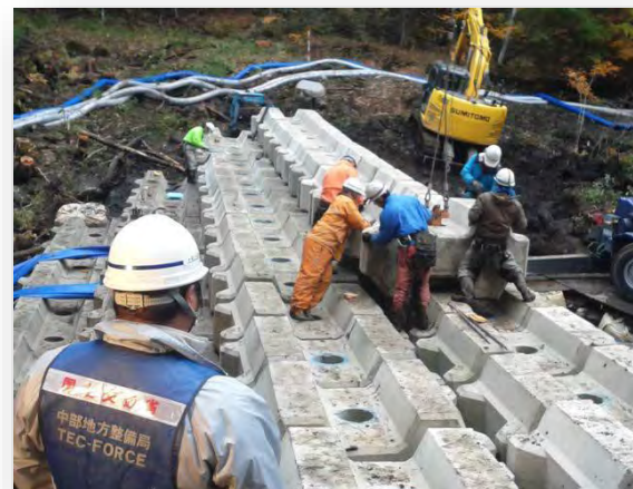
ブロック積み砂防堰堤設置の状況
