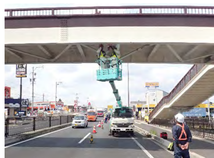
歩道橋点検（高所作業車）
