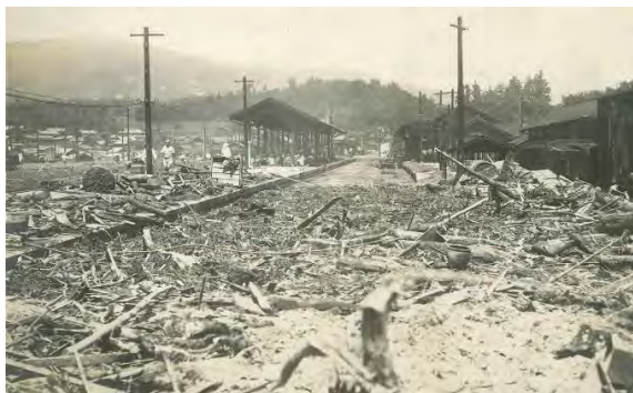
四ツ目川災害(中津川駅構内)
