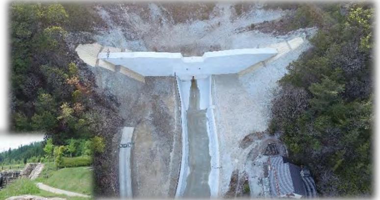
平園第6砂防堰堤
