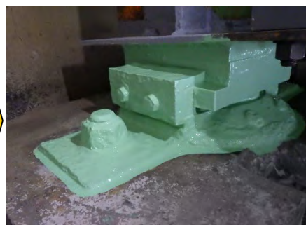
損傷部位の補修
