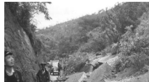
通行止めになった県道
