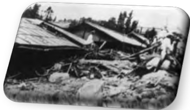
中津川市内の被災状況
