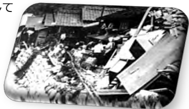
土石流に破壊された家屋
