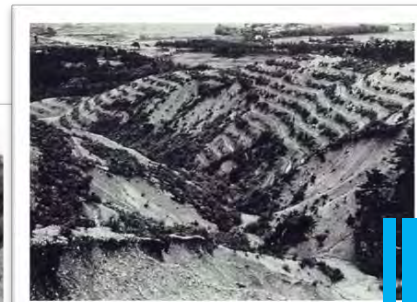
昭和20年代後半 山腹工事施工(昭和27～28年)
