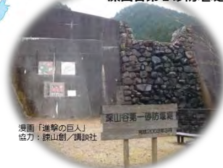
庄内川水系 深山谷第1砂防堰堤
