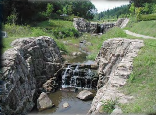
雲五川床固工群（流路工）
