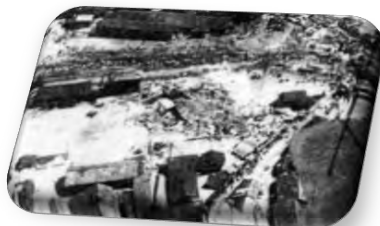
中津川市内の被災状況
