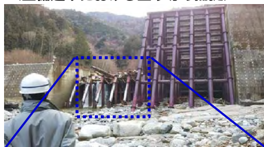
鋼管部の高さが日本一の透過型ハイダム堰堤 R3年3月完成
