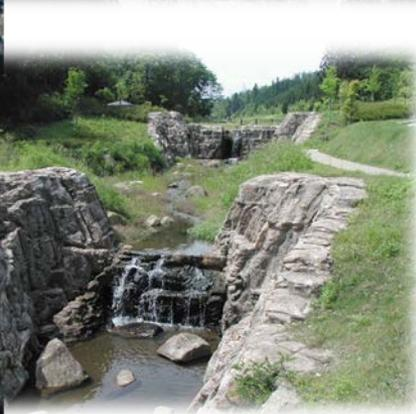
雲五川床固工群（流路工）
