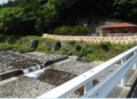
大型土のうによる護岸の高上げ
