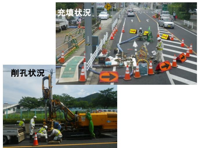
亜炭坑充填工事の様子
