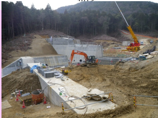
①砂防堰堤の施工
