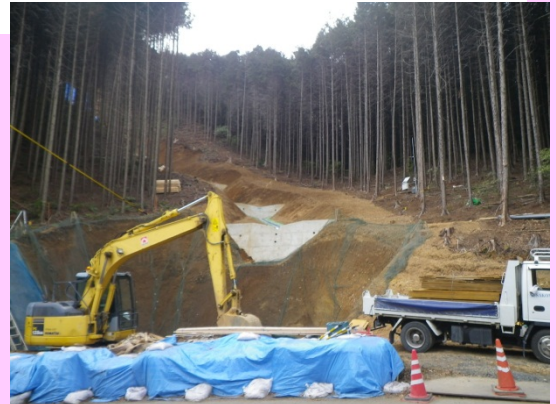
②山腹工の施工
