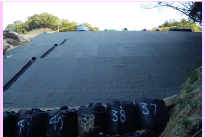
② 法尻から見た施工状況
