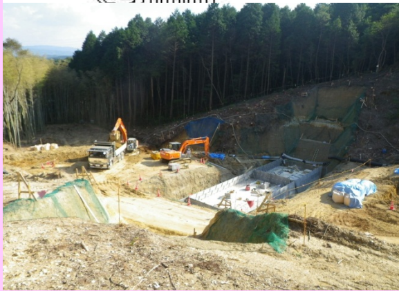
①砂防堰堤の施工
