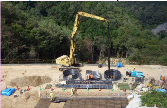
① 国道21号から見た施工状況
