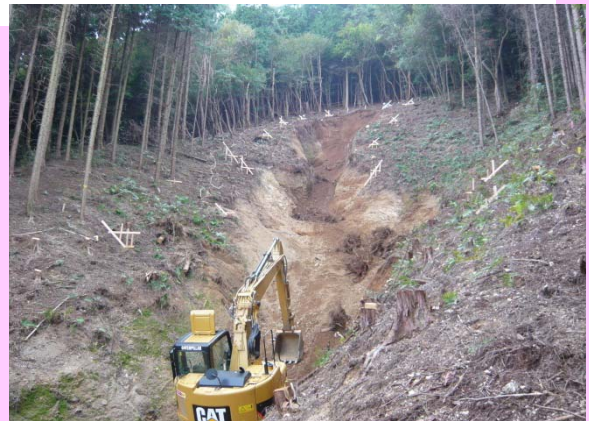
②山腹工の施工
