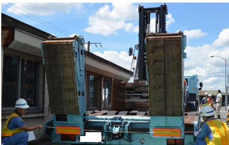
車両重量・寸法を測定し、違反がないか確認
