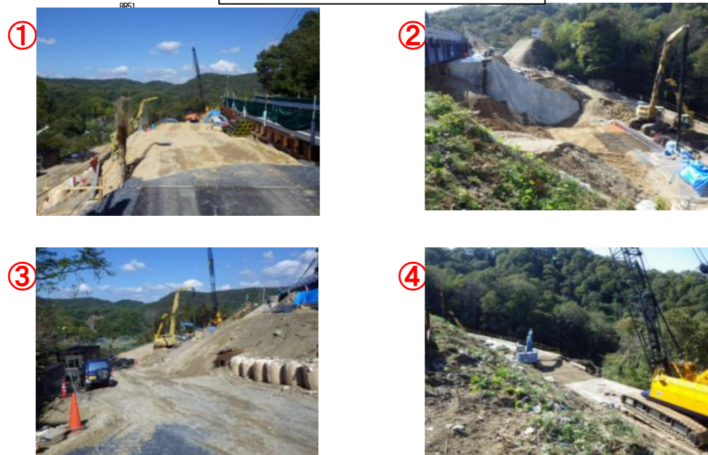
工事進捗状況写真(H24.10.25時)
