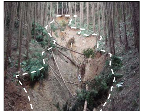
崩壊箇所(谷止工計画地点)
