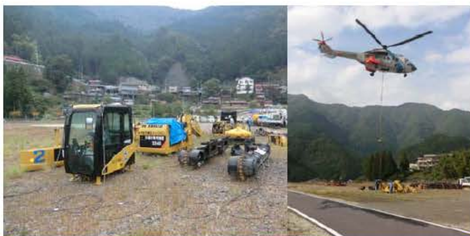
空輸状況(H23台風12号奈良県にて)
