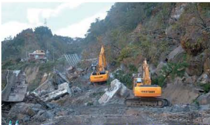
遠隔操縦による崩落土砂の撤去
