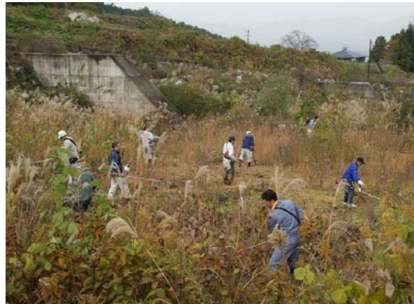
秋の四ッ目川遊砂工の作業風景
