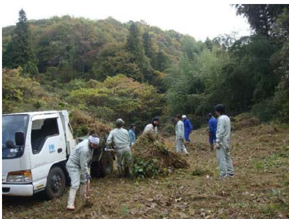
秋の子野川床固工群の作業風景
