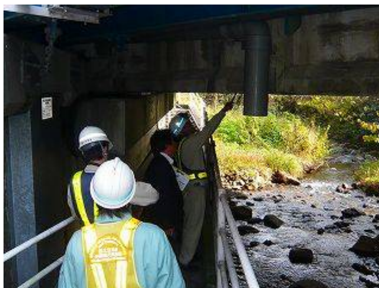
主桁の点検状況
