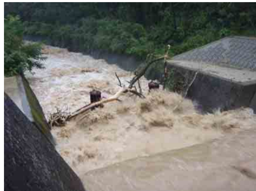
流木捕捉状況
