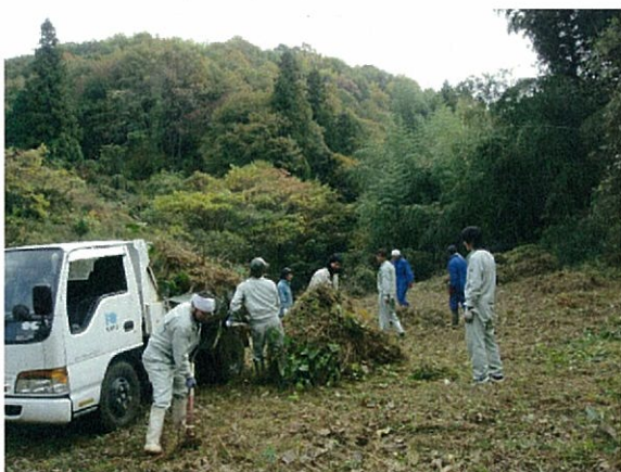
秋の子野川床固工群の作業風景
