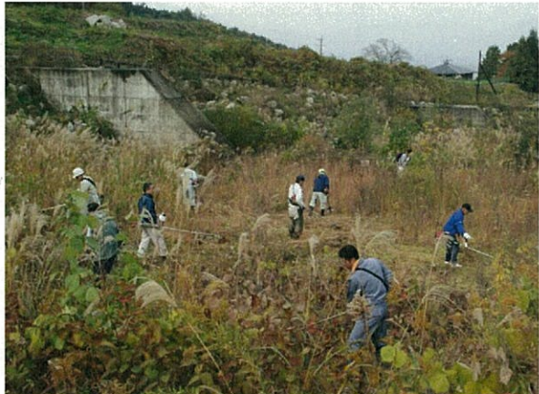
秋の四ッ目川遊砂工の作業風景
