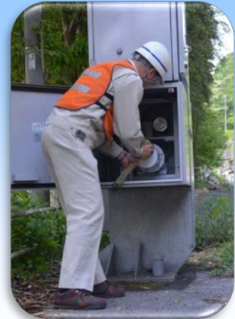
手動による遮断機降下訓練
