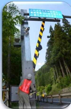
手動による遮断機降下訓練
