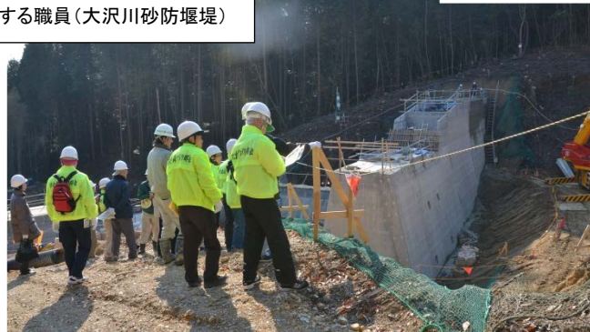
砂防堰堤の施工状況
