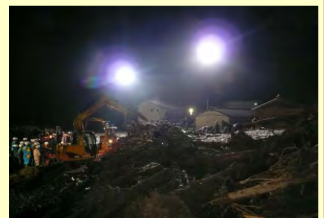
照明点灯による夜間救出作業
