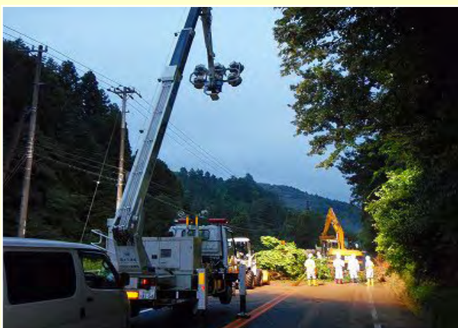
土砂撤去の作業支援
