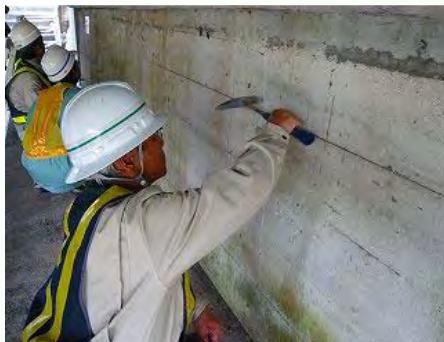
橋台のクラック箇所の叩き点検
