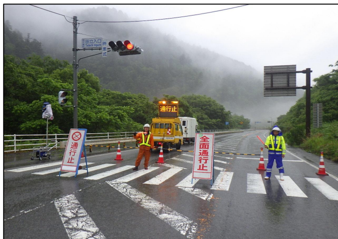
R6.6.28 通行止めの様子 (田立入口交差点)
