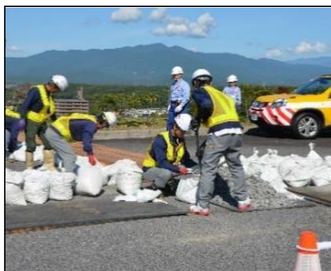
路面段差の解消
