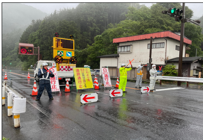
R6.6.28 通行止めの様子(弥栄橋交差点)
