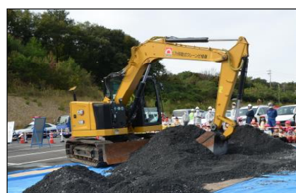
⑤土砂の排除による道路啓開
