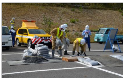
①路面段差解消
