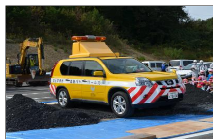
道路啓開完了
