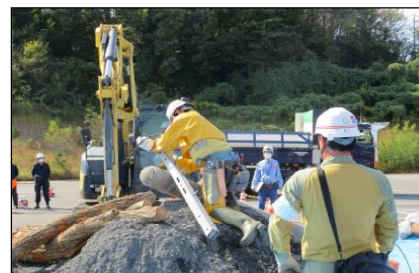
③電柱の排除
