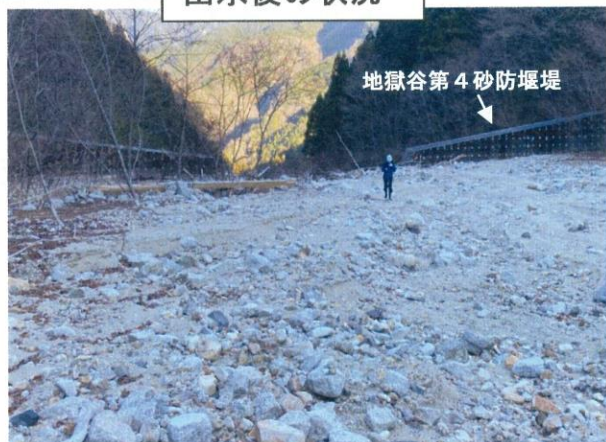
出水後の状況
