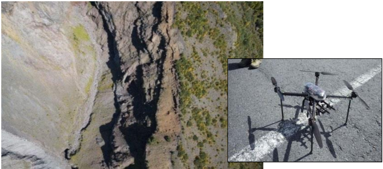
UAV(無人航空機)による調査
