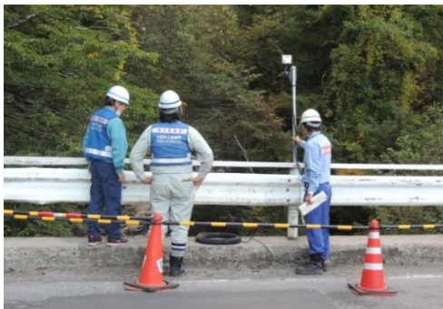
土石流の発生に備え監視カメラを設置
