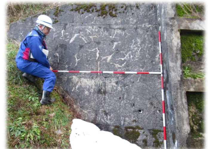
急傾斜地の被災状況調査
