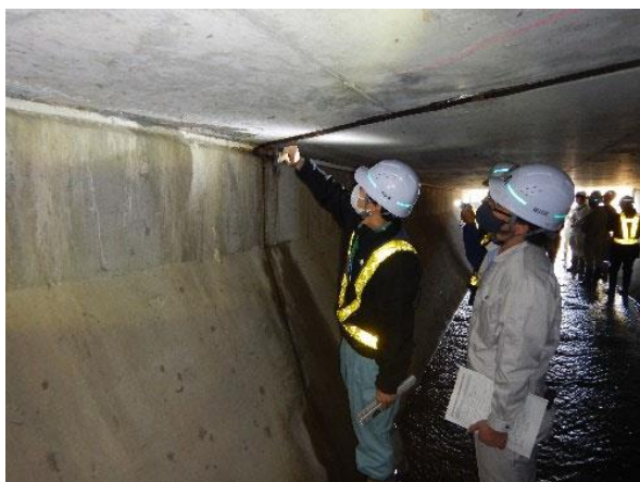
橋梁点検講習会の様子
