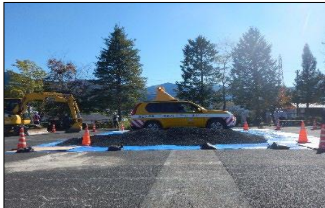
道路啓開完了
