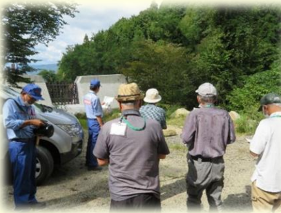
不透過型から部分透過型に改修された下平次第8砂防堰堤
