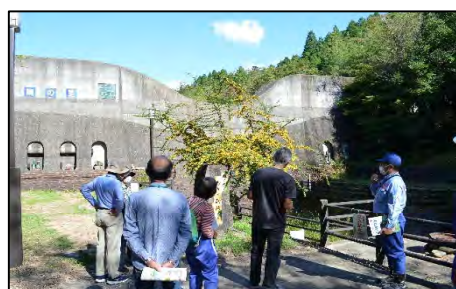
砂防堰堤の見学
