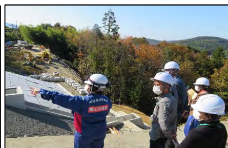
災害復旧工事現場の見学
