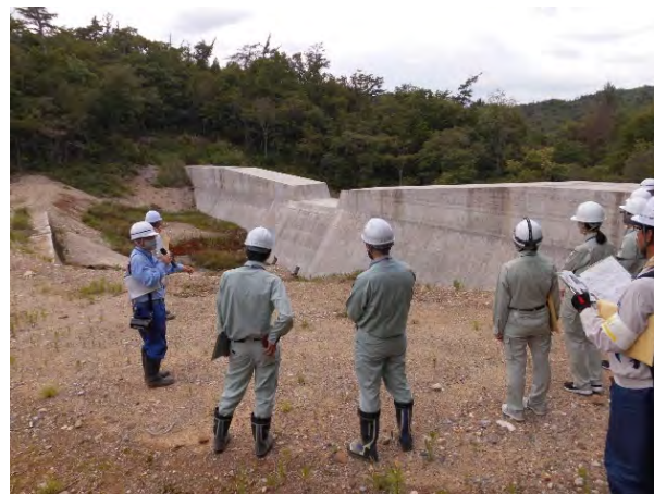
砂防施設の点検 [砦山第4砂防堰堤]
