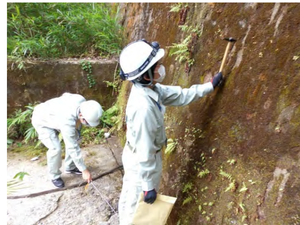
砂防施設の点検(打音検査) [砦山第7砂防堰堤]
