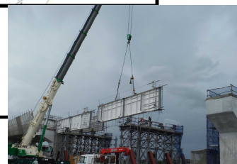
作業内容：桁架設 （イメージ写真）
