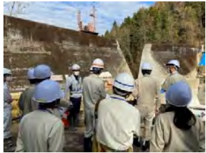
現場代理人による工事概要説明 （下平次第8砂防堰堤改築工事）
