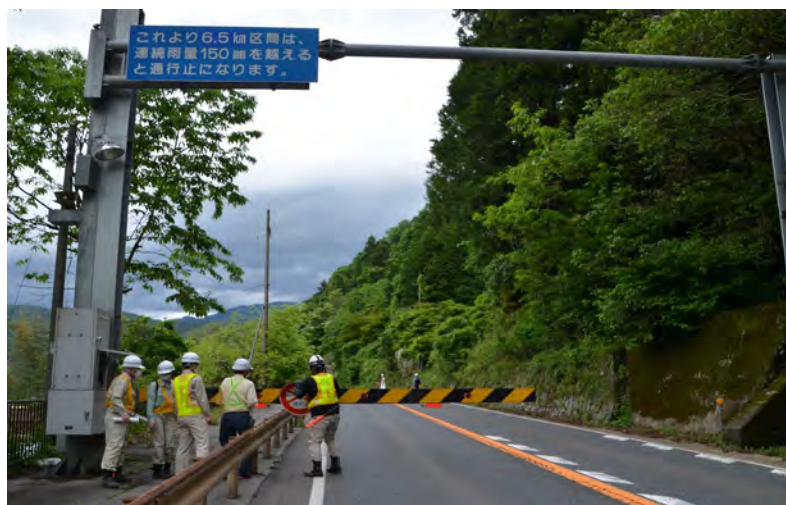
遮断機は車道の両側についており、ゲートを下ろし通行規制訓練（一時通行止め）を行います。
